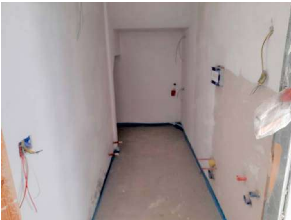
Bagno e rip. sottoscala
