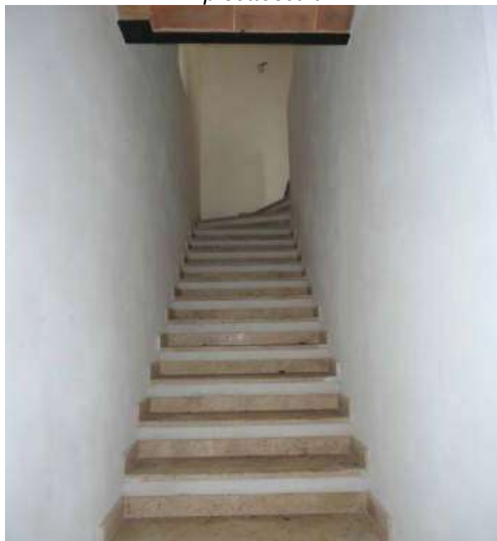
Scala di collegamento
