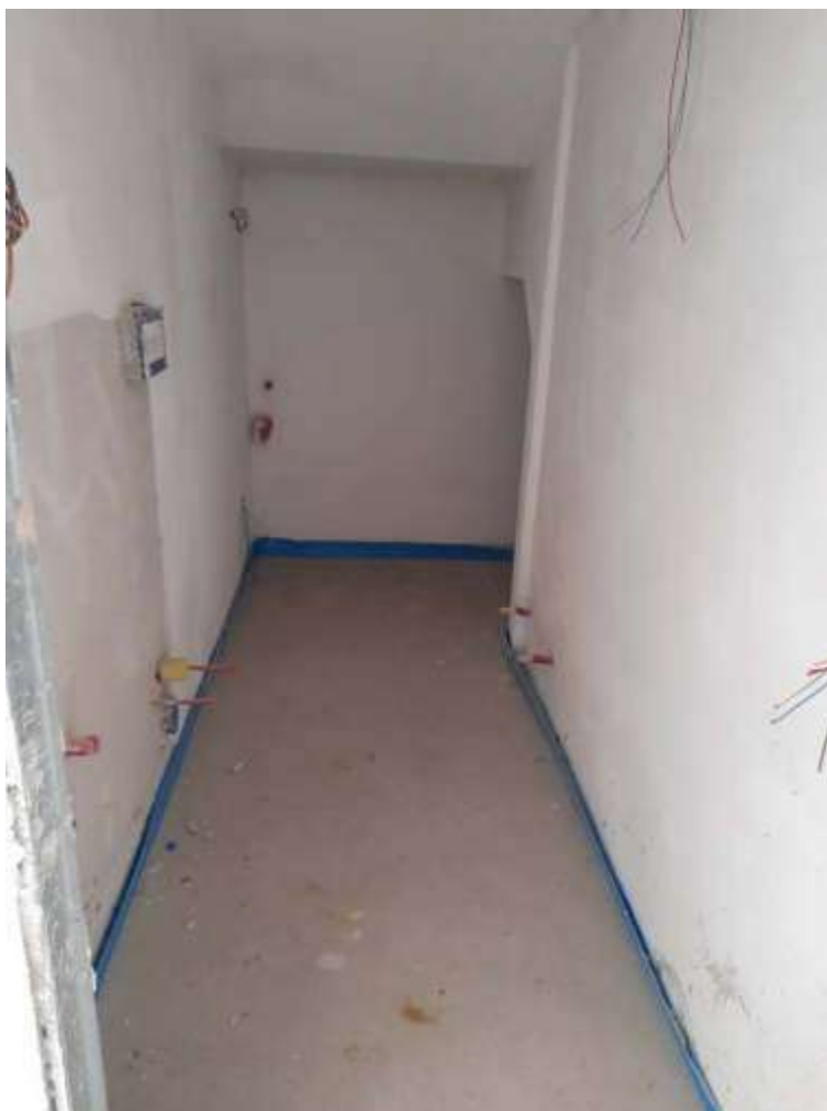
Bagno e rip. sottoscala
