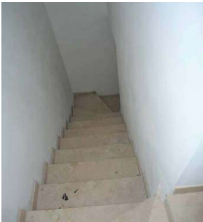
Scala di collegamento
