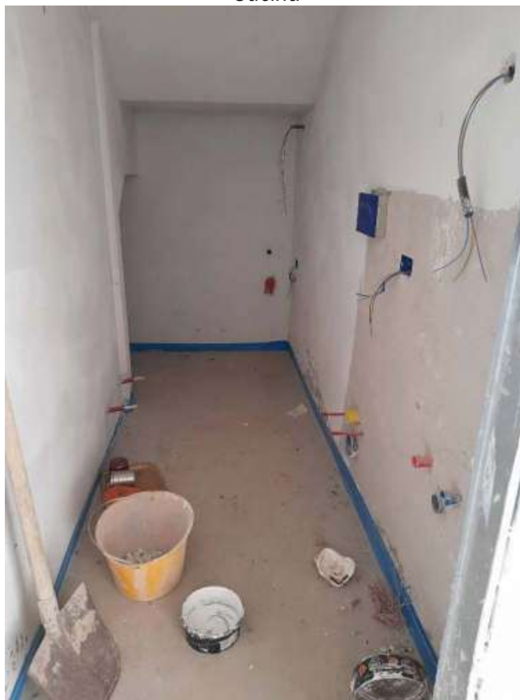
Bagno e rip. sottoscala
