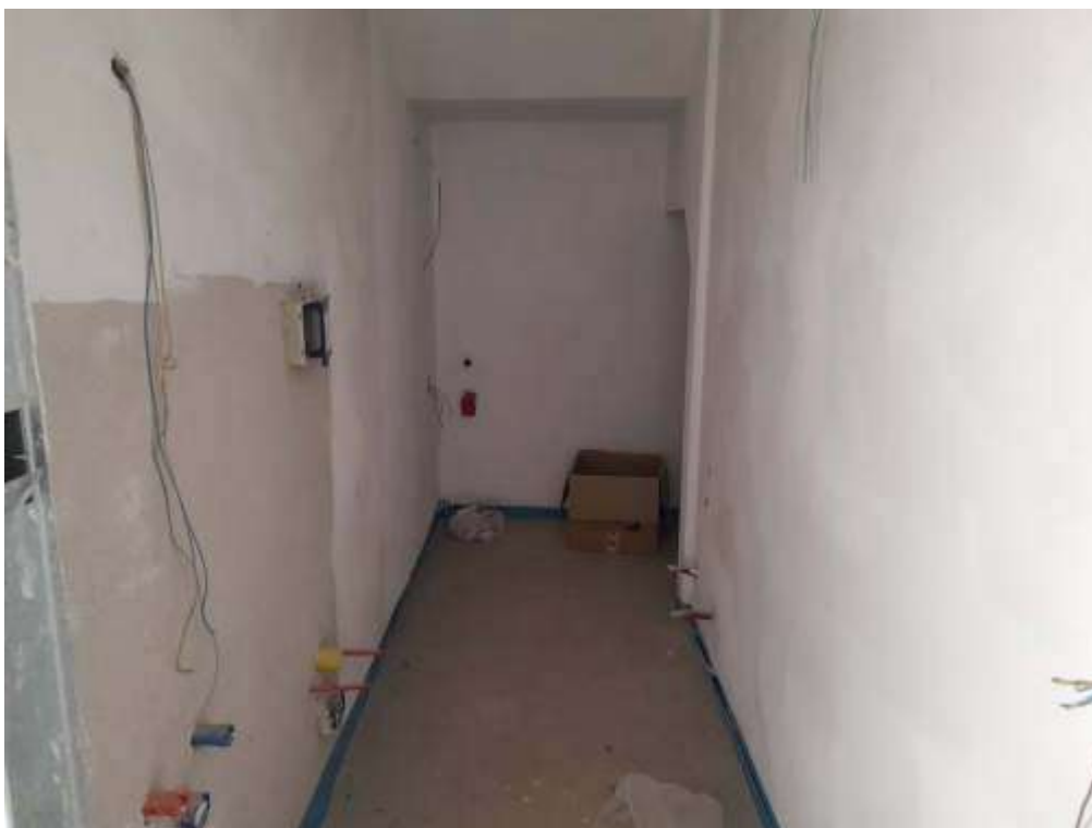
Bagno e rip. sottoscala
