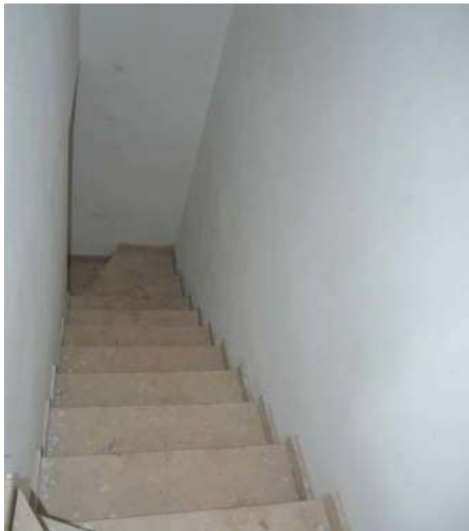
Scala di collegamento
