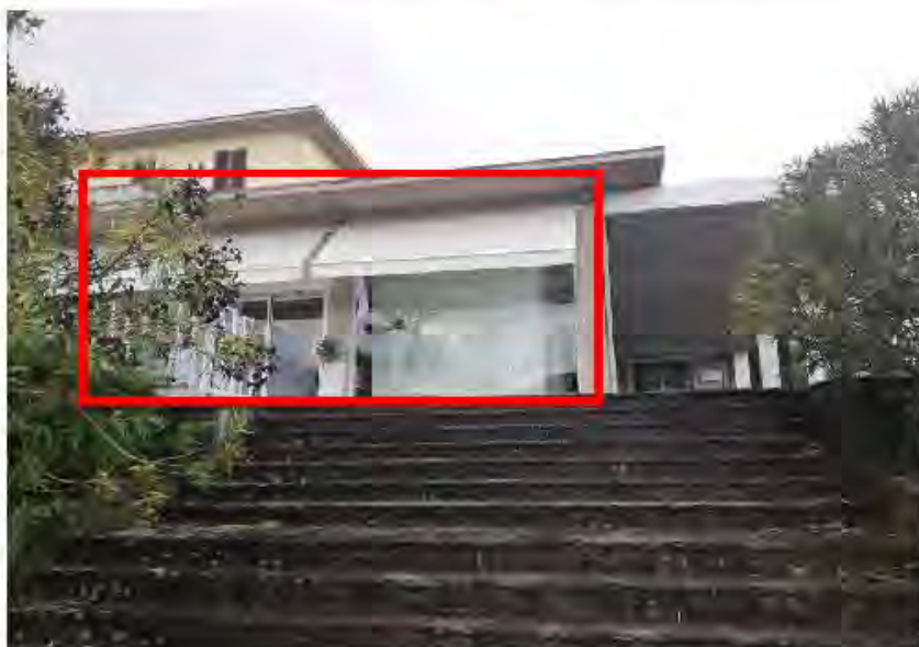
VISTA DAL MARCIAPIEDE
