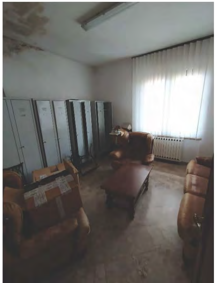
Spogliatoio donne (vista 2)
