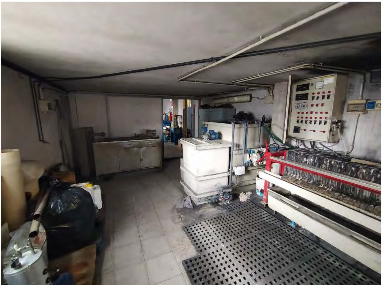
Labor. Locale h 2 metri (vista 2)
