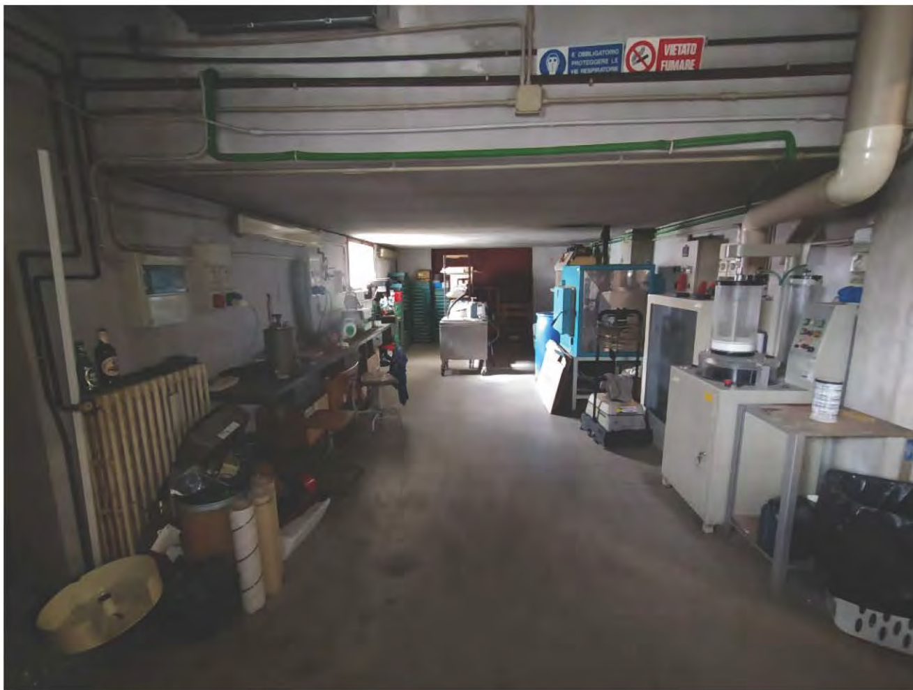
Labor. Locale h 2 metri (vista 1)
