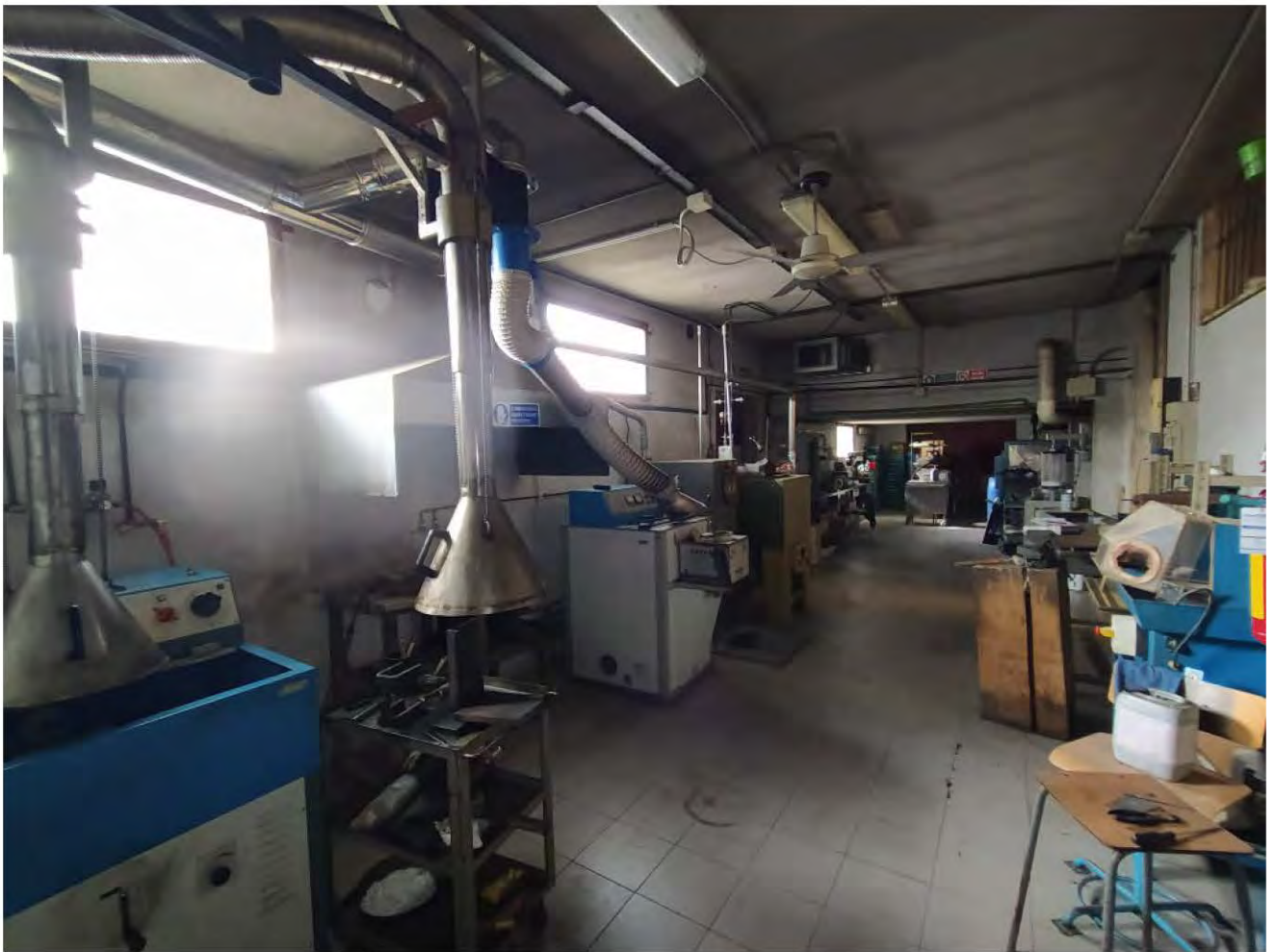
Labor. Locale h 3 metri (vista 1)
