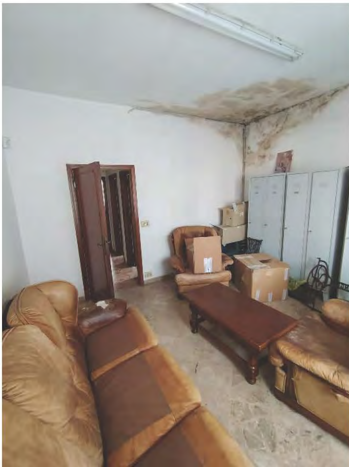
Spogliatoio donne (vista 1)
