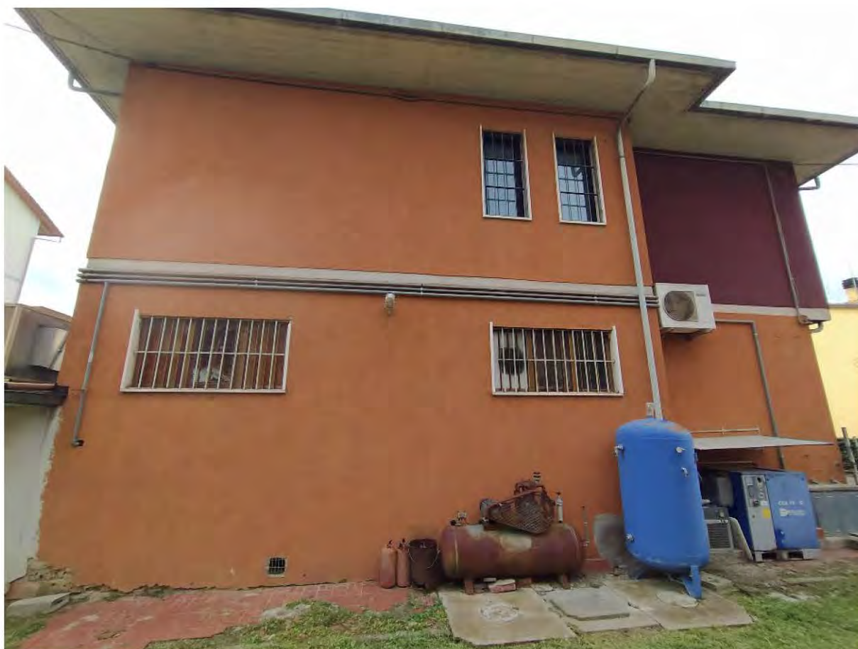
Vista facciata SUD-EST
