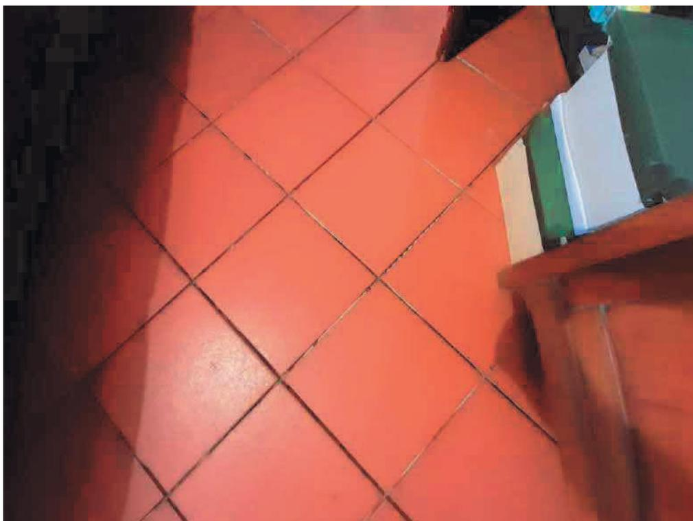
Particolare della pavimentazione priva di stuccatura delle fughe
