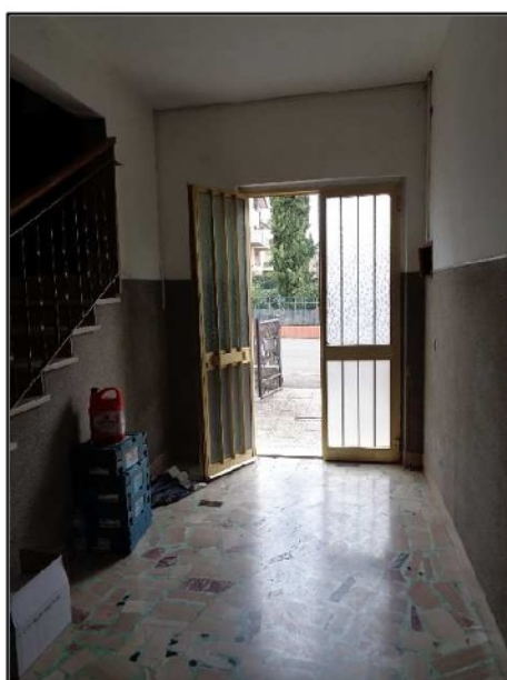
FOTO 9 - VANO SCALE CONDOMINIALE
