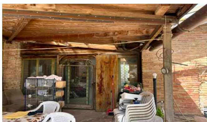
Tettoia aperta e tettoia con tamponamenti verticali
