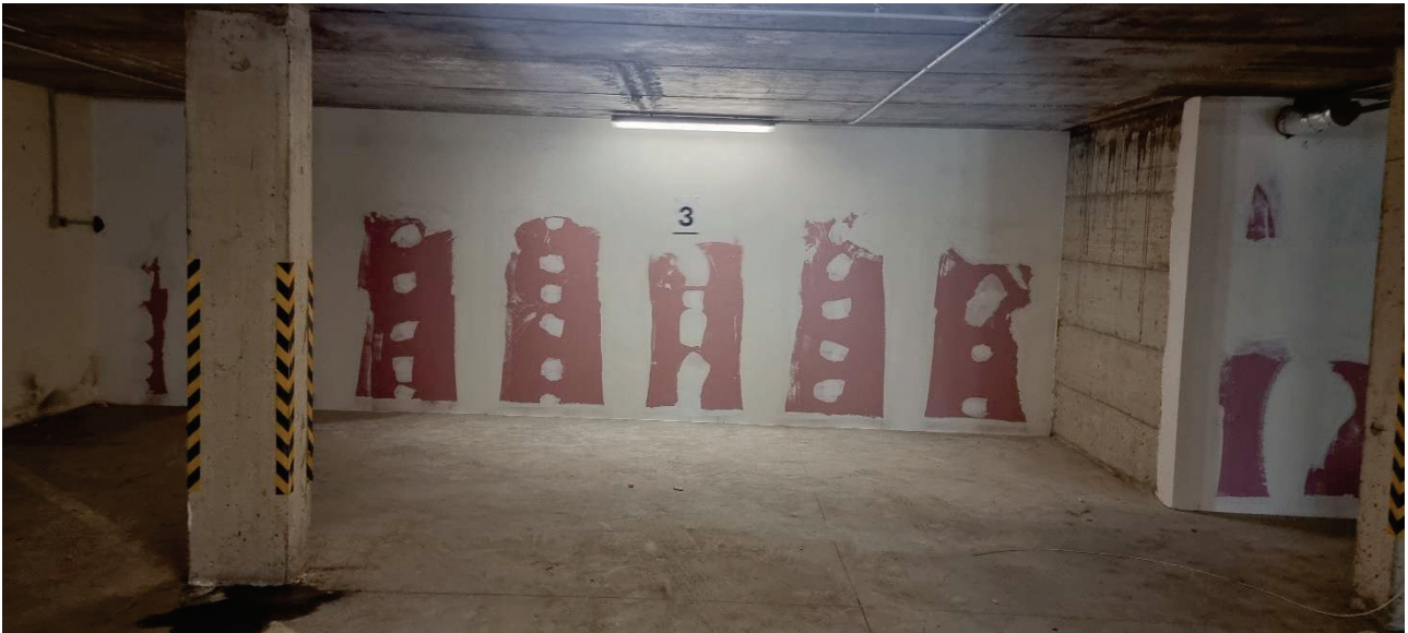
Posto auto in autorimessa comune
