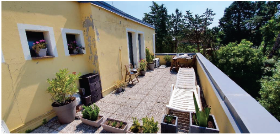
Esterno lato sud
