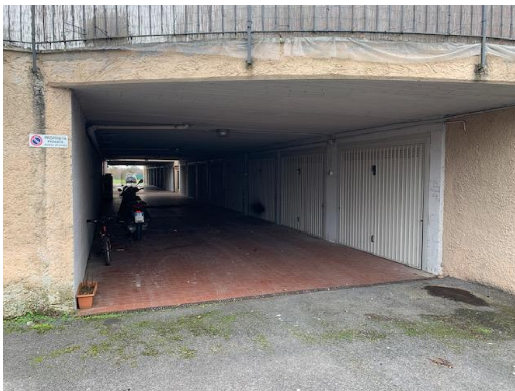
FOTO 15 – Vista corsia autorimesse
