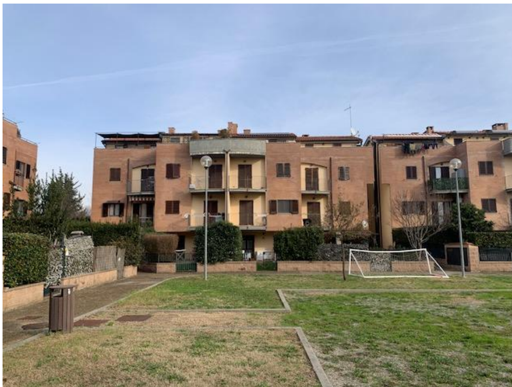
FOTO 1 – Vista esterna fabbricato
