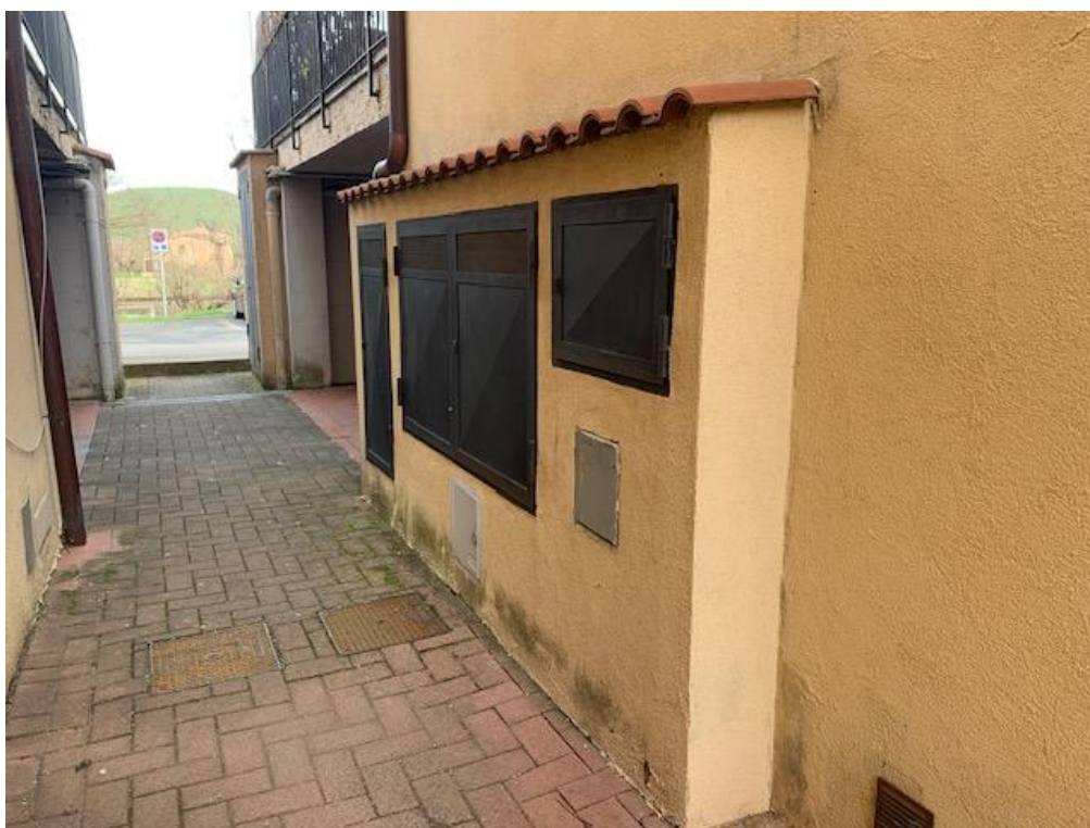
FOTO 18 – Vista zona vano contatori
