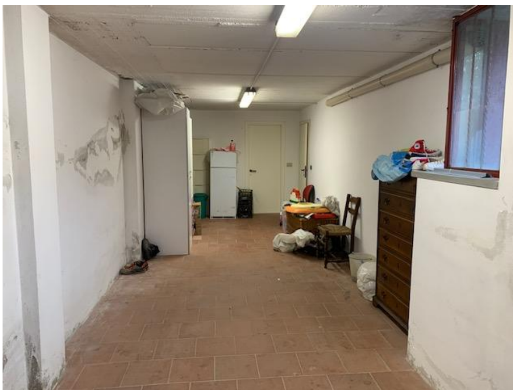
FOTO 22 – Vista interna dell'autorimessa
