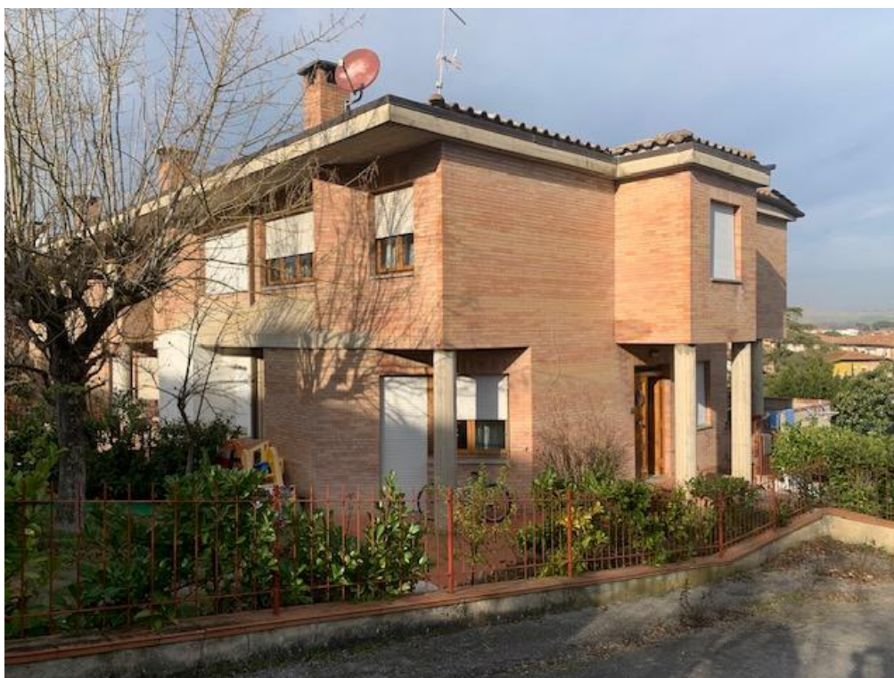
FOTO 3– Vista esterna sud est fabbricato
