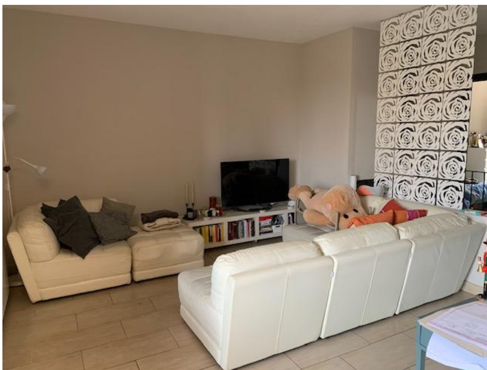
FOTO 6 – Vista ingresso soggiorno (da ripristinare zona cottura)
