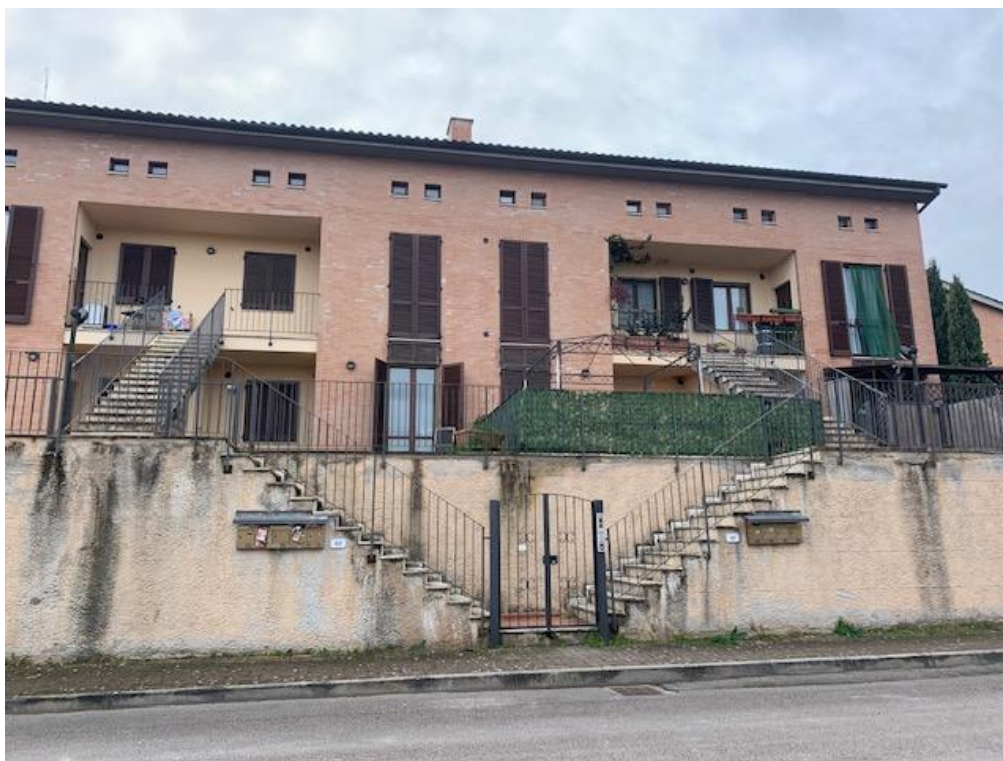
FOTO 2 – Vista esterna fabbricato
