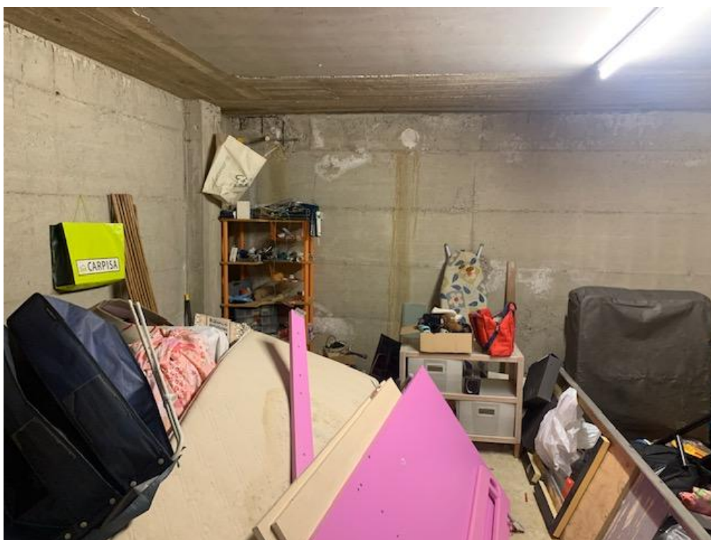
FOTO 20 – Vista locale accessorio interrato
