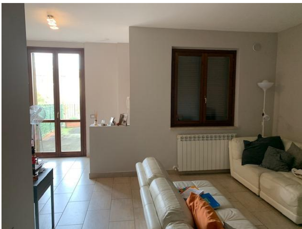
FOTO 5 – Vista ingresso soggiorno (da ripristinare zona cottura)
