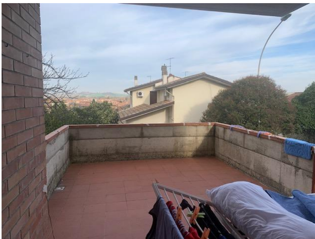
FOTO 10 – Vista lastrico solare
