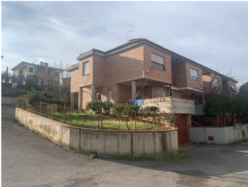
FOTO 1 – Vista esterna nord est fabbricato
