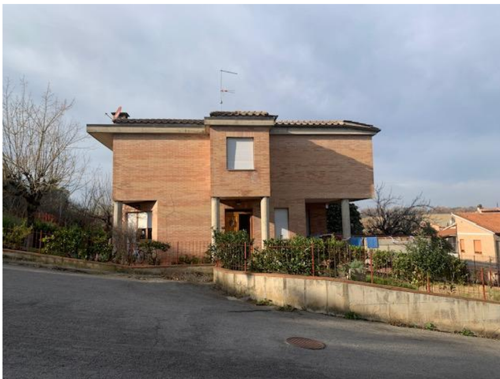
FOTO 2 – Vista esterna ovest fabbricato
