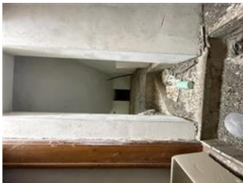
Vista dell'accesso al Piano Sottotetto del Piano Primo.
