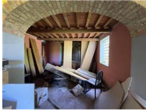
Vista del Soggiorno dalla Camera del Piano Terra.
