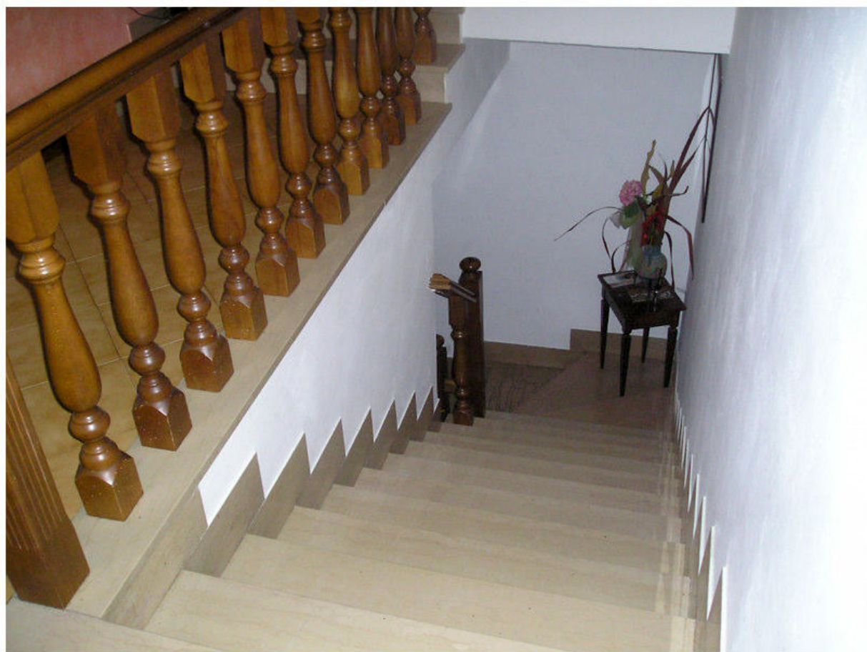
FOTOGRAFIA 06 - Interno / Vano Scala
