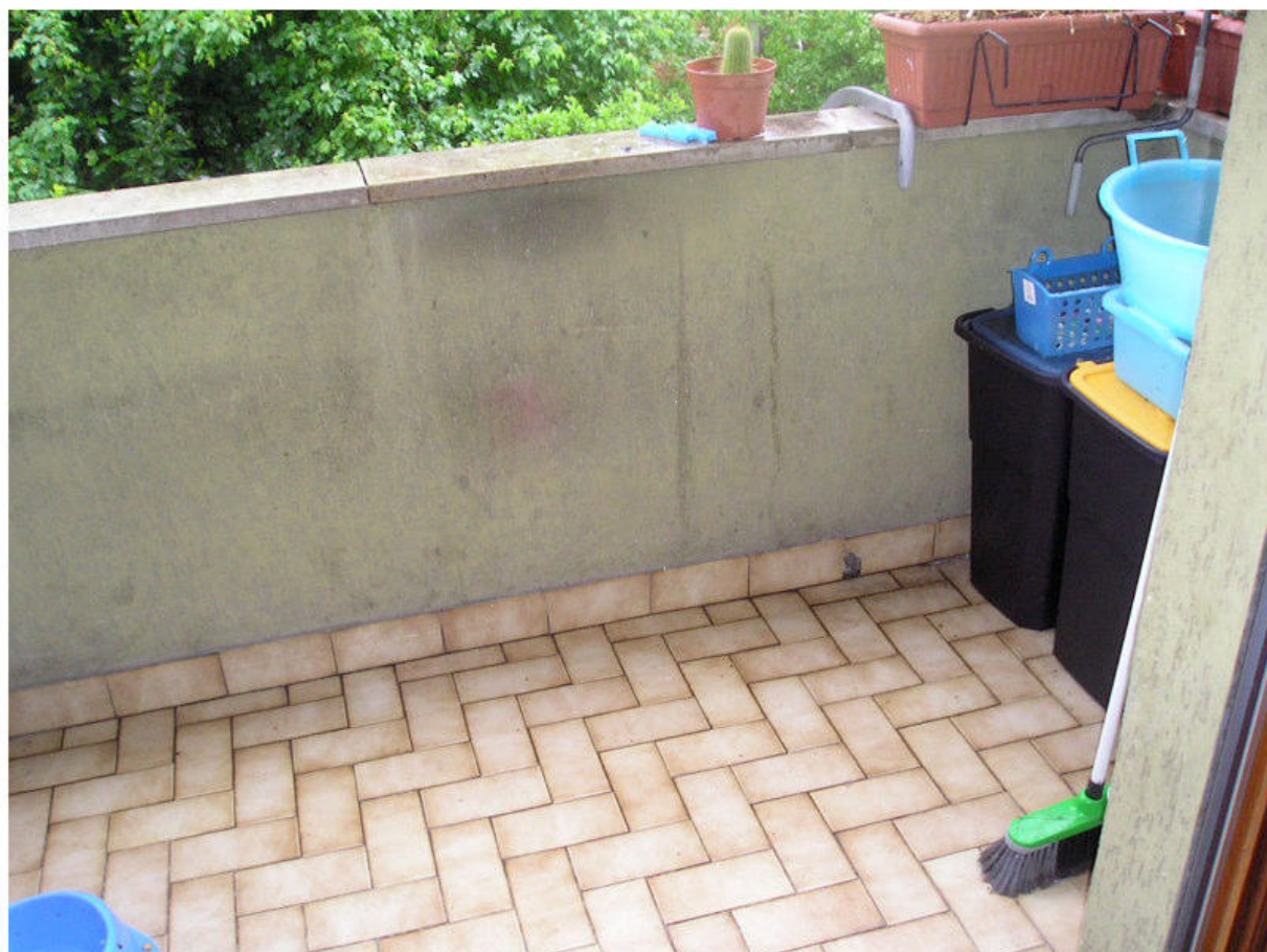
FOTOGRAFIA 18 - Particolare Interno Balcone
