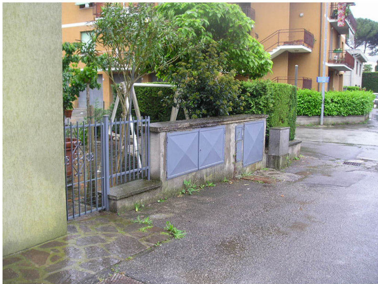
FOTOGRAFIA 32 - Piazzale Esterno Comune / Vani Utenze
