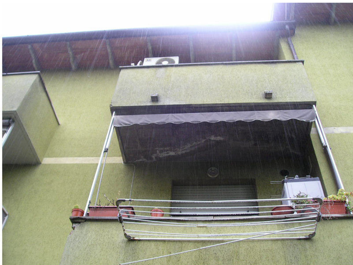
FOTOGRAFIA 04 - Esterno Fabbricato / Retro - Facciata / Balconi
