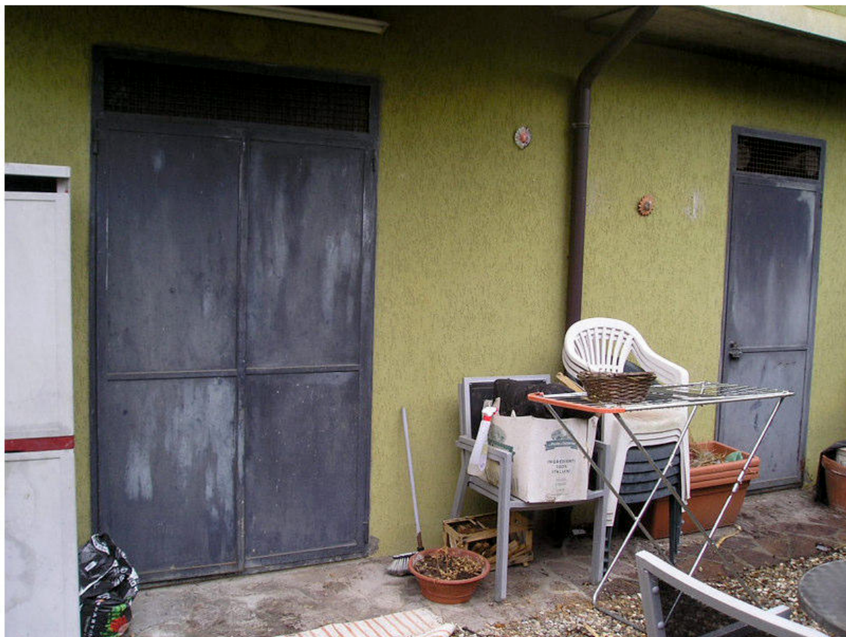
FOTOGRAFIA 25 - Esterno / Ingresso C.T.
