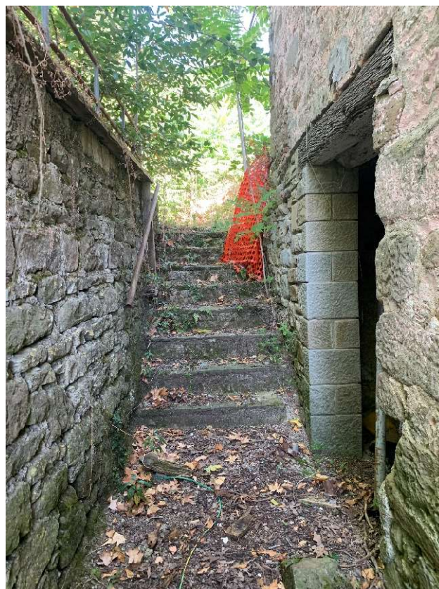
Scala esterna che conduce al piano Seminterrato
