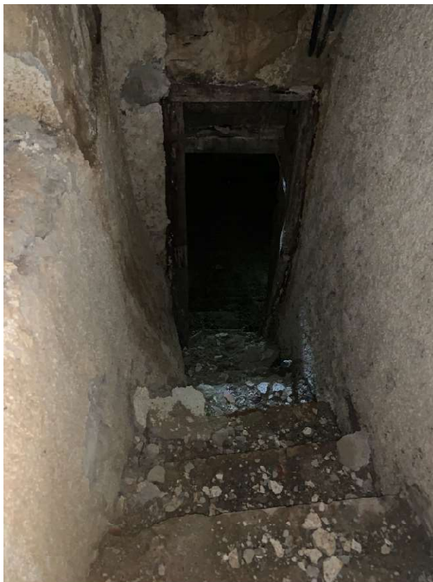
Scala che conduce al piano interrato
