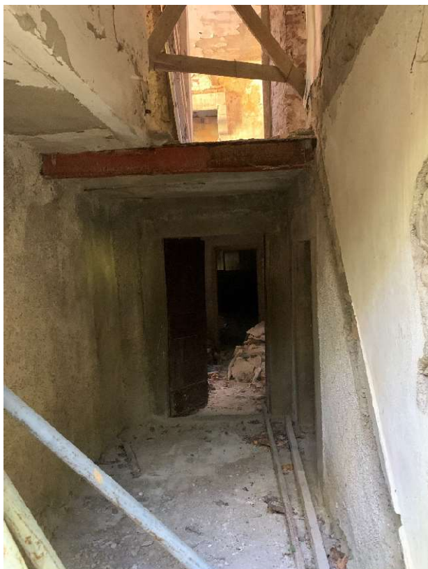
Solaio tra P.T. e Piano seminterrato
