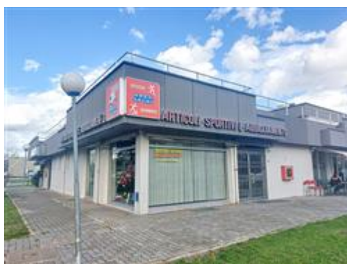
Scorcio del fabbricato da Via Fiorentina/angolo Via Antonio Stoppani
