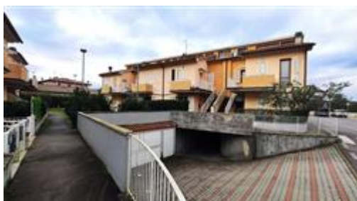
Rampa condominiale di accesso al piano interrato
