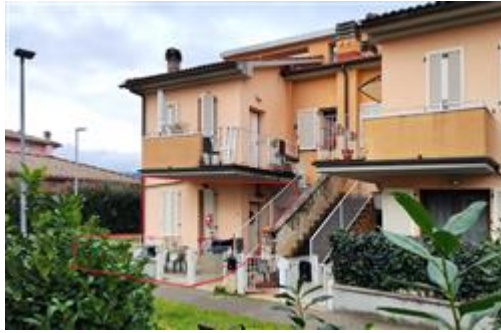
Vista dal vialetto condominiale del prospetto principale
