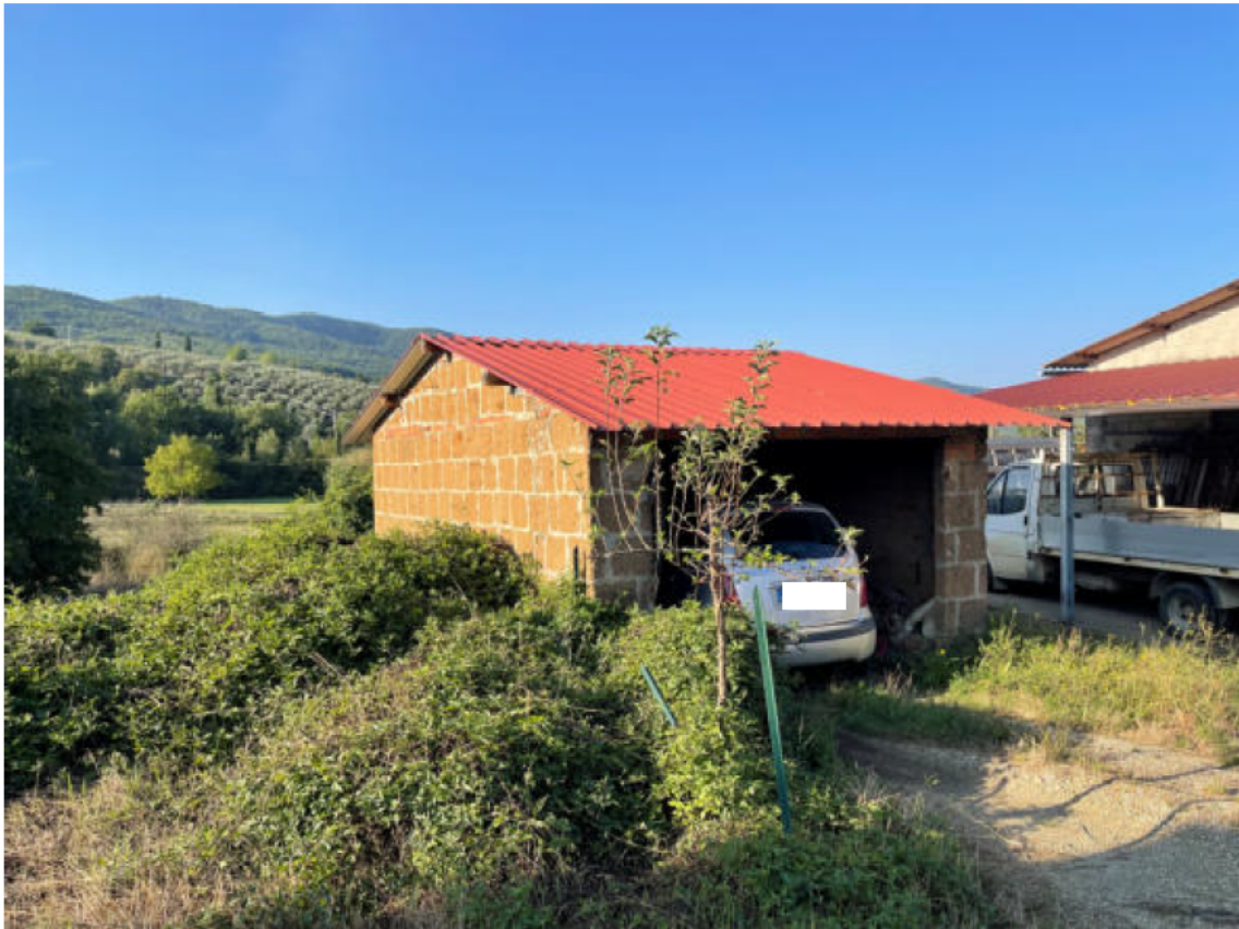
EDIFICIO SECONDARIO PICCOLO
