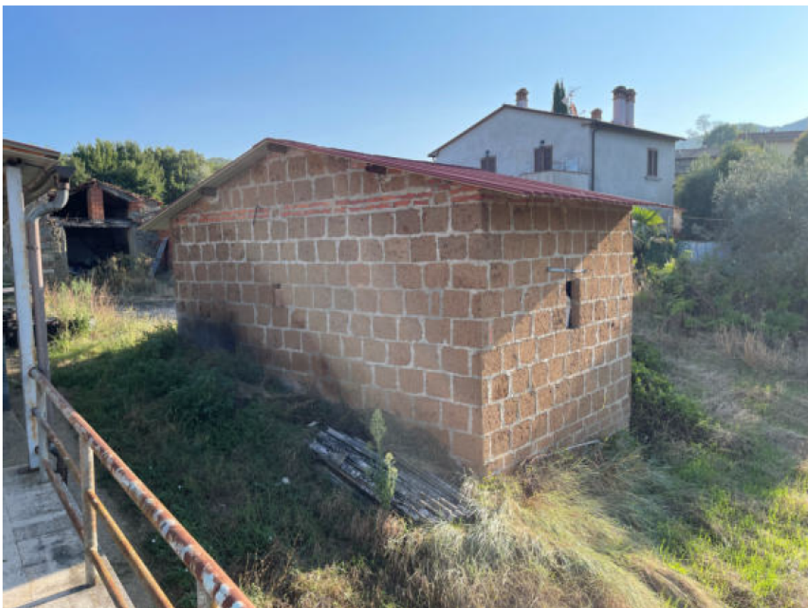
EDIFICIO SECONDARIO PICCOLO
