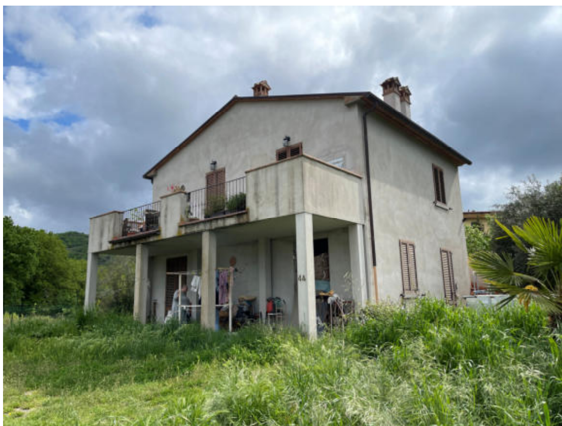
Fronte e lato destro
