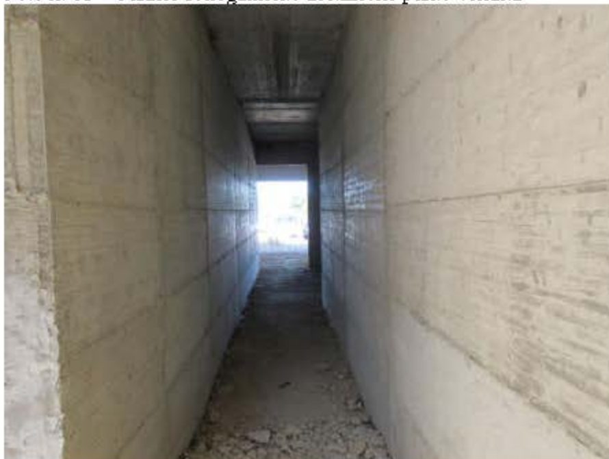
Foto n. 18 – Tunnel collegamento abitazione punto vendita
