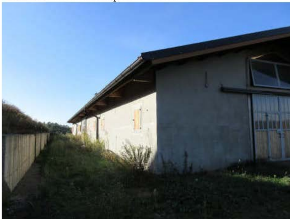
Foto n. 23 – Scuderia – Prospetti Nord - Est
