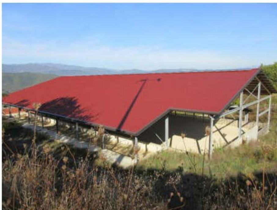
Foto n. 35 – Maneggio coperto – copertura
