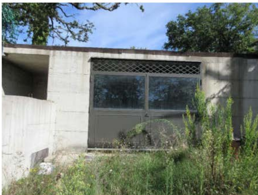
Foto n. 20 – Edificio D – Piano interrato
