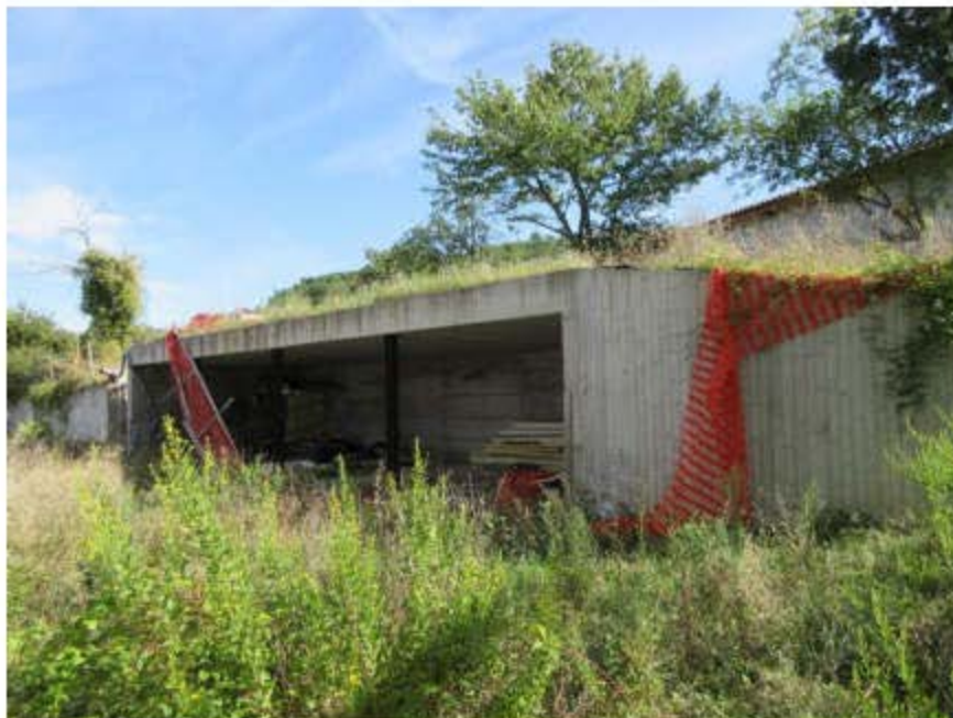
Foto n. 19 – Locale deposito acqua e finimenti cavalli
