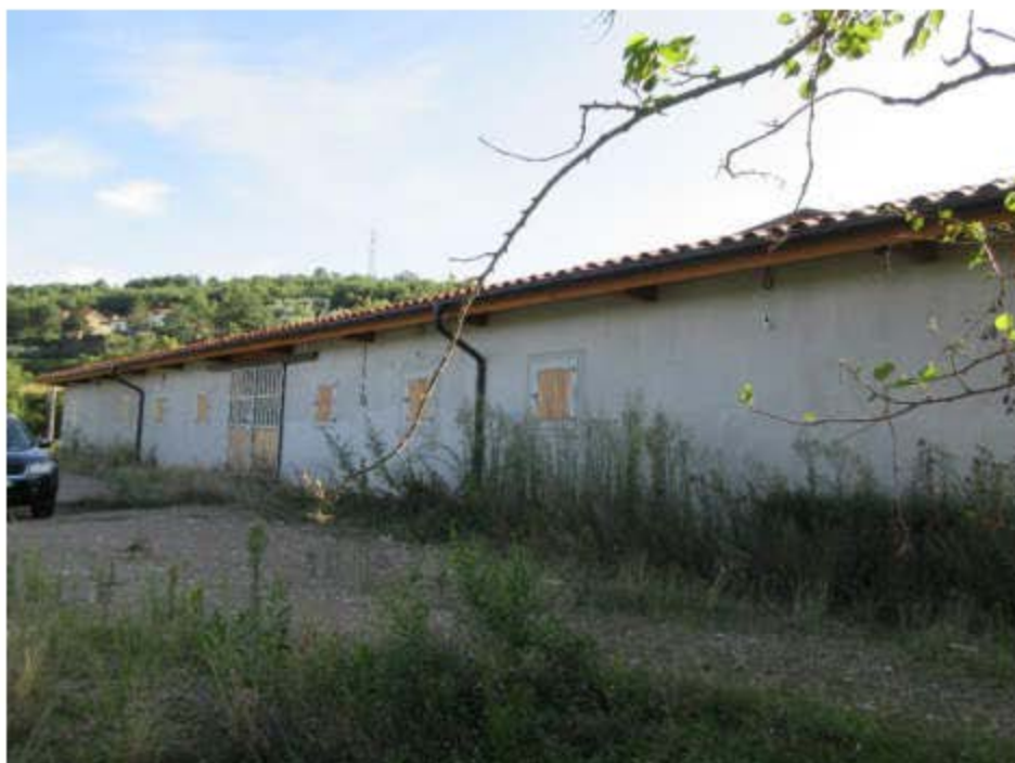
Foto n. 24 – Scuderia – Prospetto Ovest
