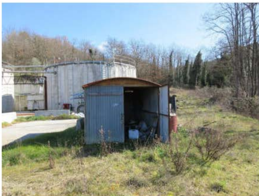
Foto 59 – Impianto – locale deposito
