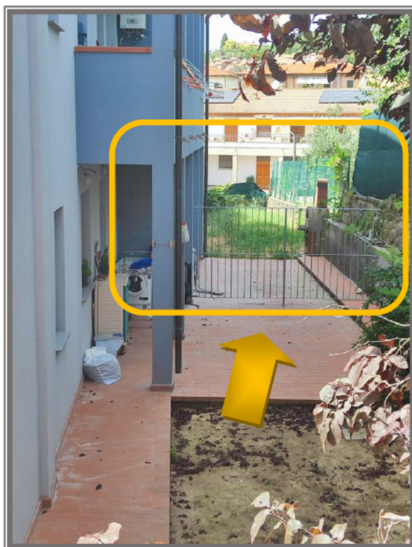
Fotografia 2 – Prospetto nel retro in evidenza il sub. 5 di proprietà esclusiva Sig.re Piscopo Salvatore
