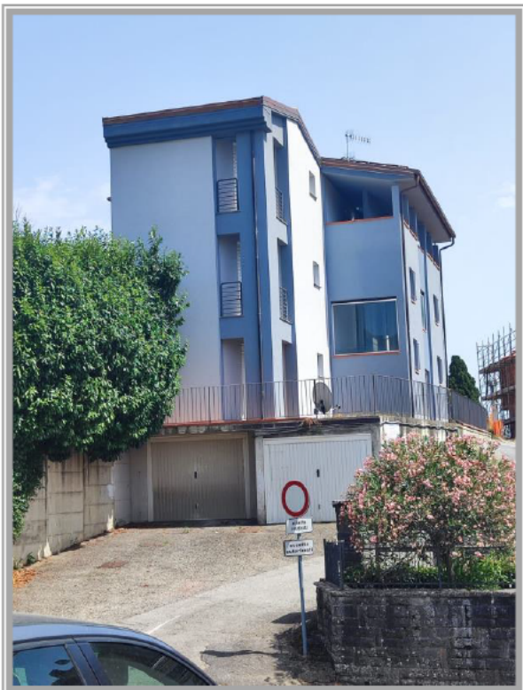
Fotografia 1 – Prospetto Lato Strada
