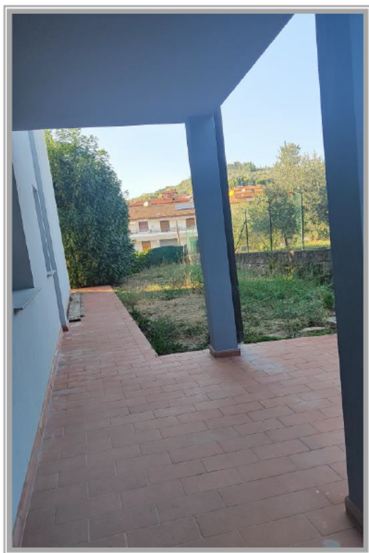
Fotografia 16 – Dettaglio pavimentazione porticato
