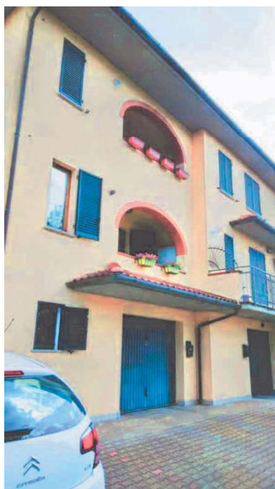
Foto 03 – Esterno (Via di Sinalunga)
