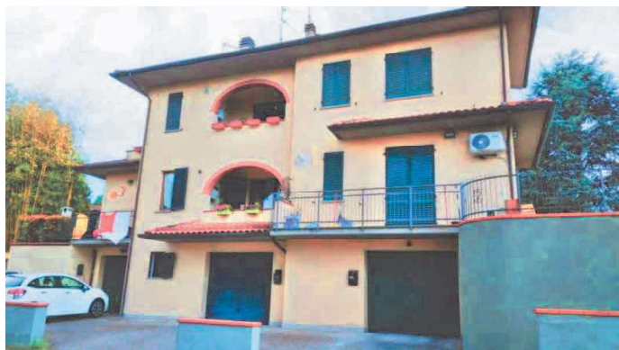
Foto 01 – Esterno (Via di Sinalunga)
