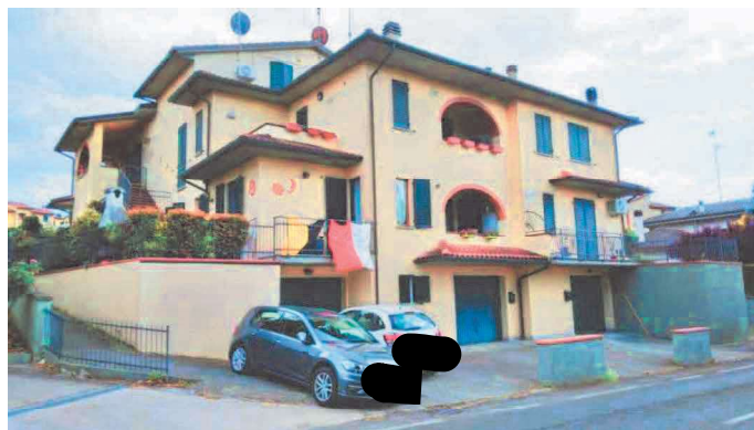
Foto 02 – Esterno (Via di Sinalunga)
