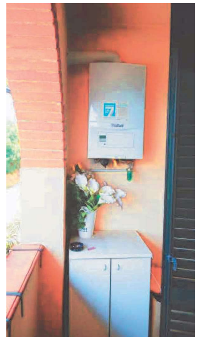
Foto 09 – Balcone, su soggiorno piano primo
