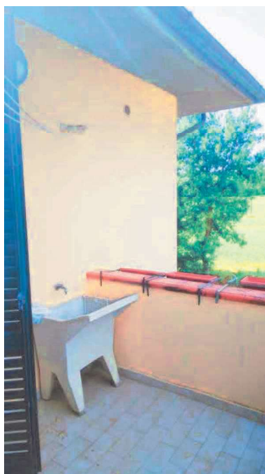
Foto 12 – Balcone su cucina, piano primo
