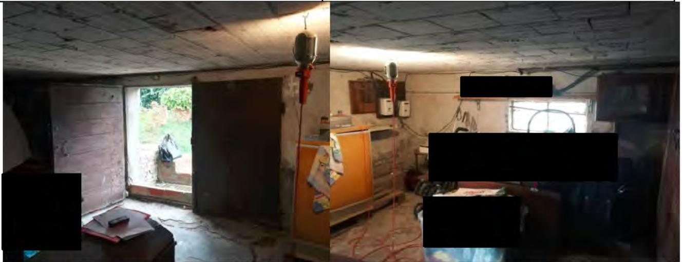
cantina piano seminterrato con soffitto stonacato in laterizio e pavimento a cemento
