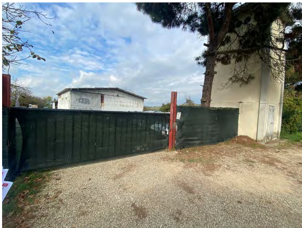
FOTO 16 PART. 651 (CABONA ELETTRICA)
