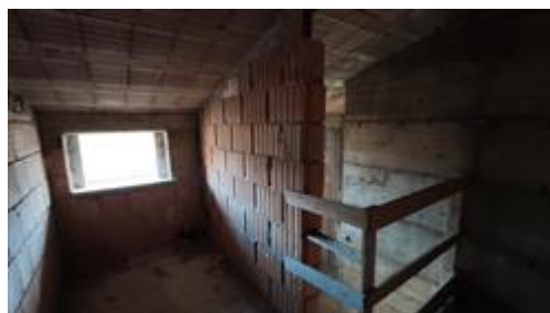
A8 - Lavanderia soffitta
