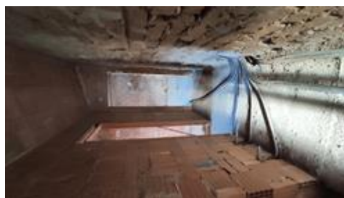
A5 - Disimpegno piano soffitta
