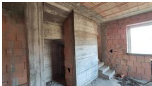
A7 - Disimpegno piano primo
