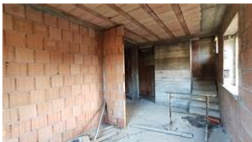
A7 - Monolocale - Parete cucina
