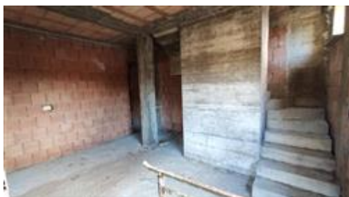
A7 - Disimpegno piano primo
