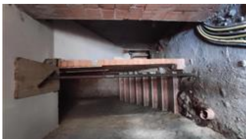
Vano scala a comune
