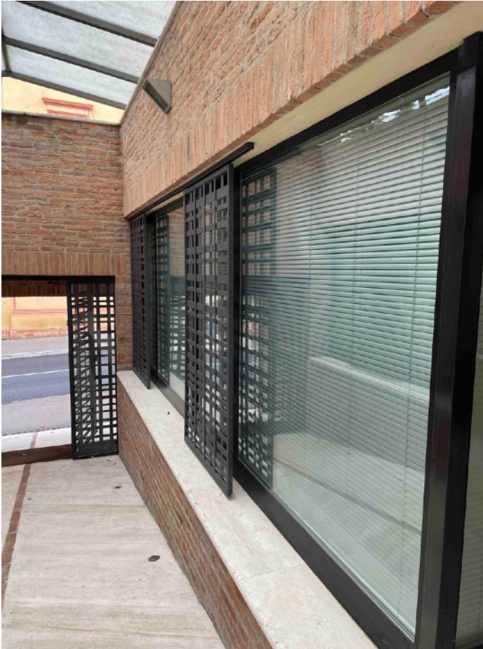
INFISSO SU RAMPA SUB. 20
