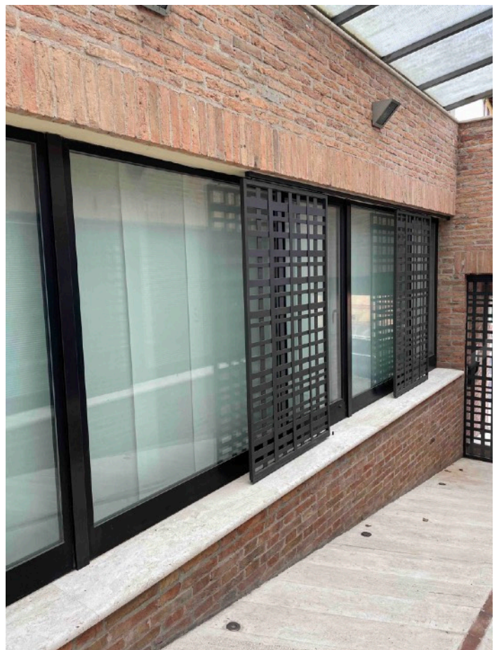
INFISSO SU RAMPA SUB. 21
