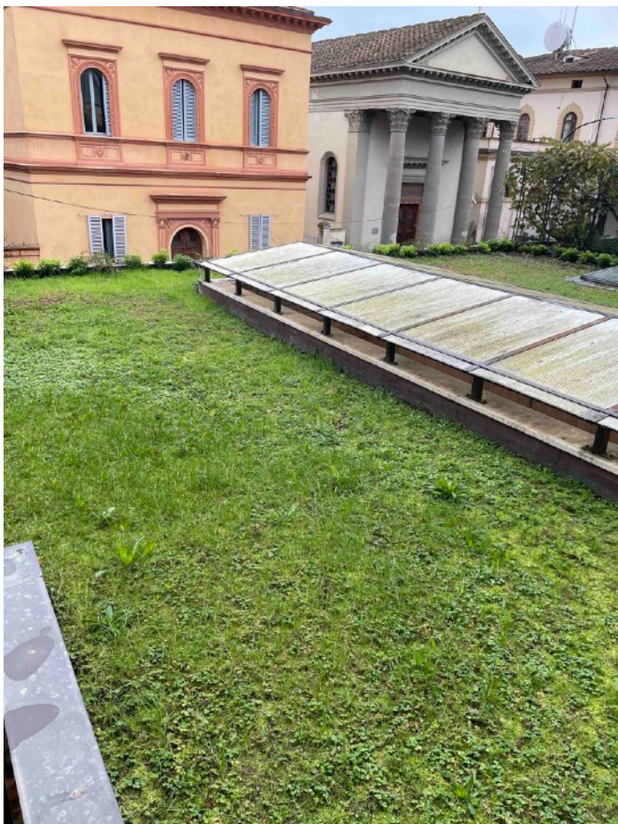
COPERTURA A VERDE UFFICI
