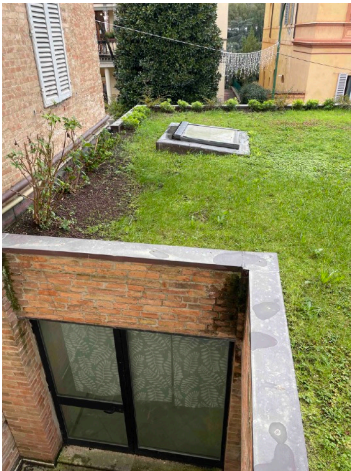
COPERTURA A VERDE UFFICI
