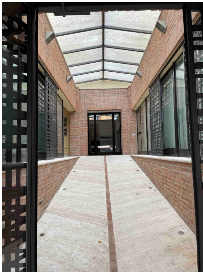
RAMPA ACCESSO CONDOMINIALE
