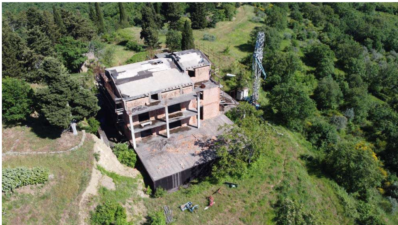
Figura 4: Vissta laterale (ovest) del fabbricato
