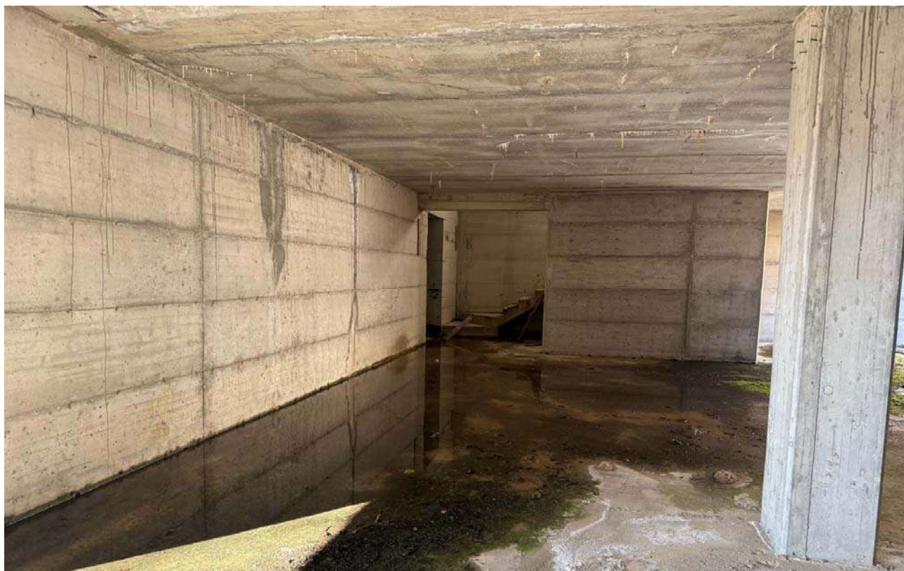
Figura 6: Interrato lato est
