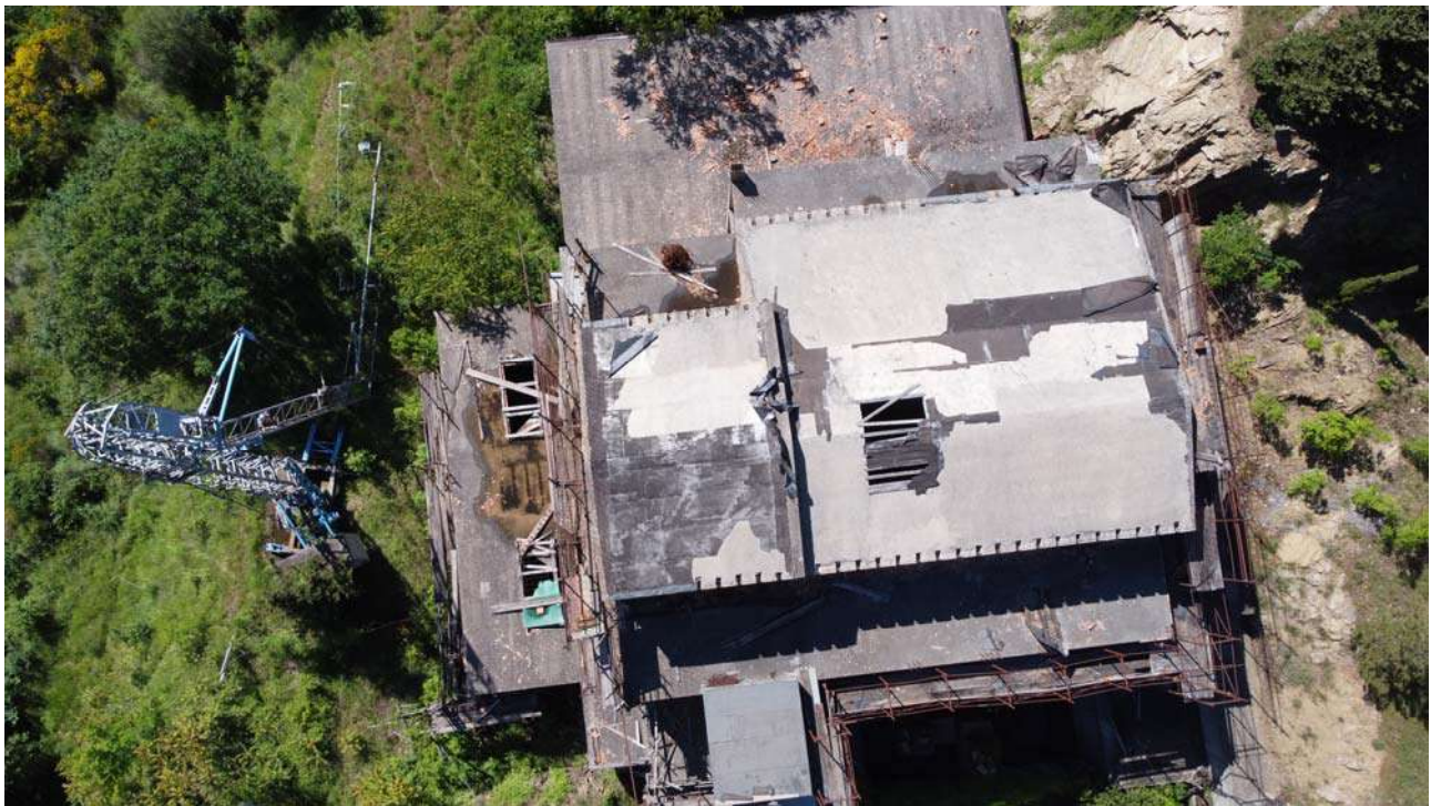
Figura 1: Vista aerea del fabbricato
