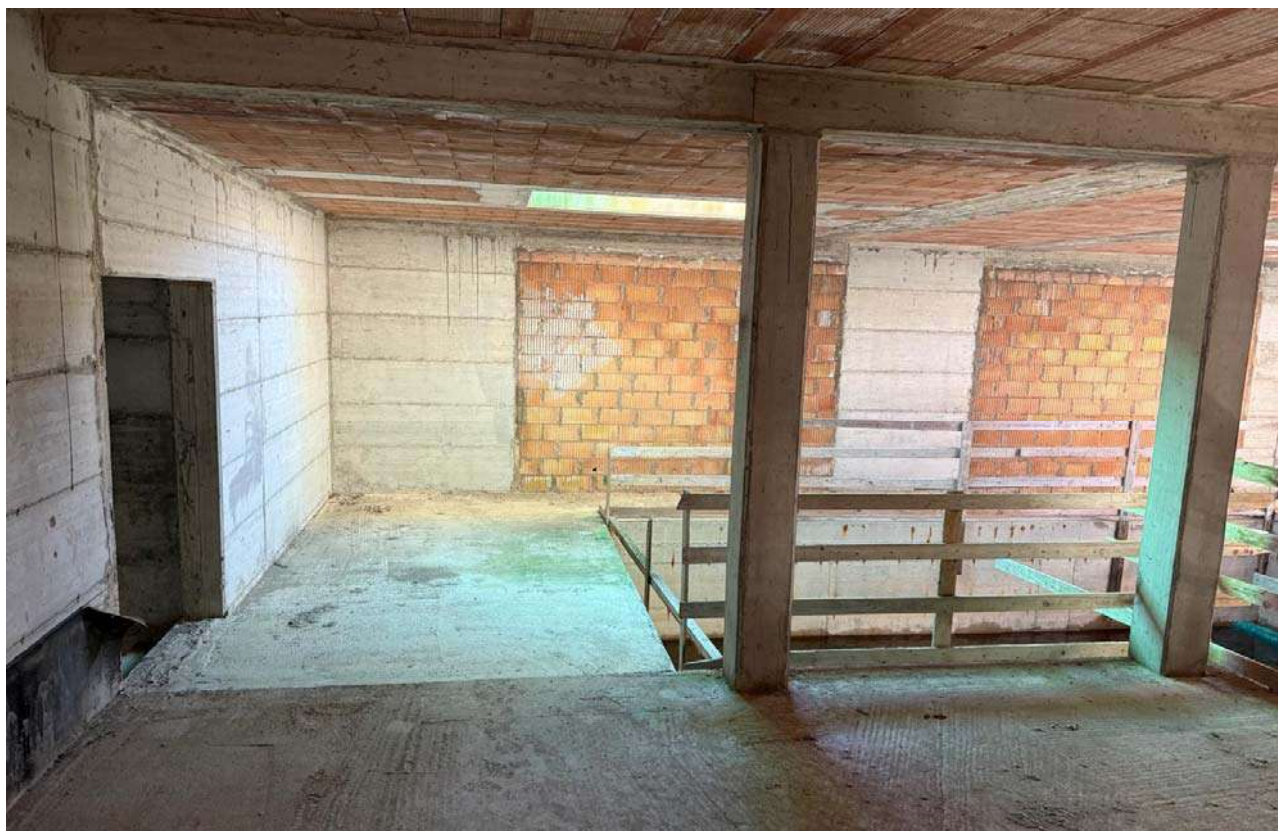
Figura 8: Interrato lato sud
