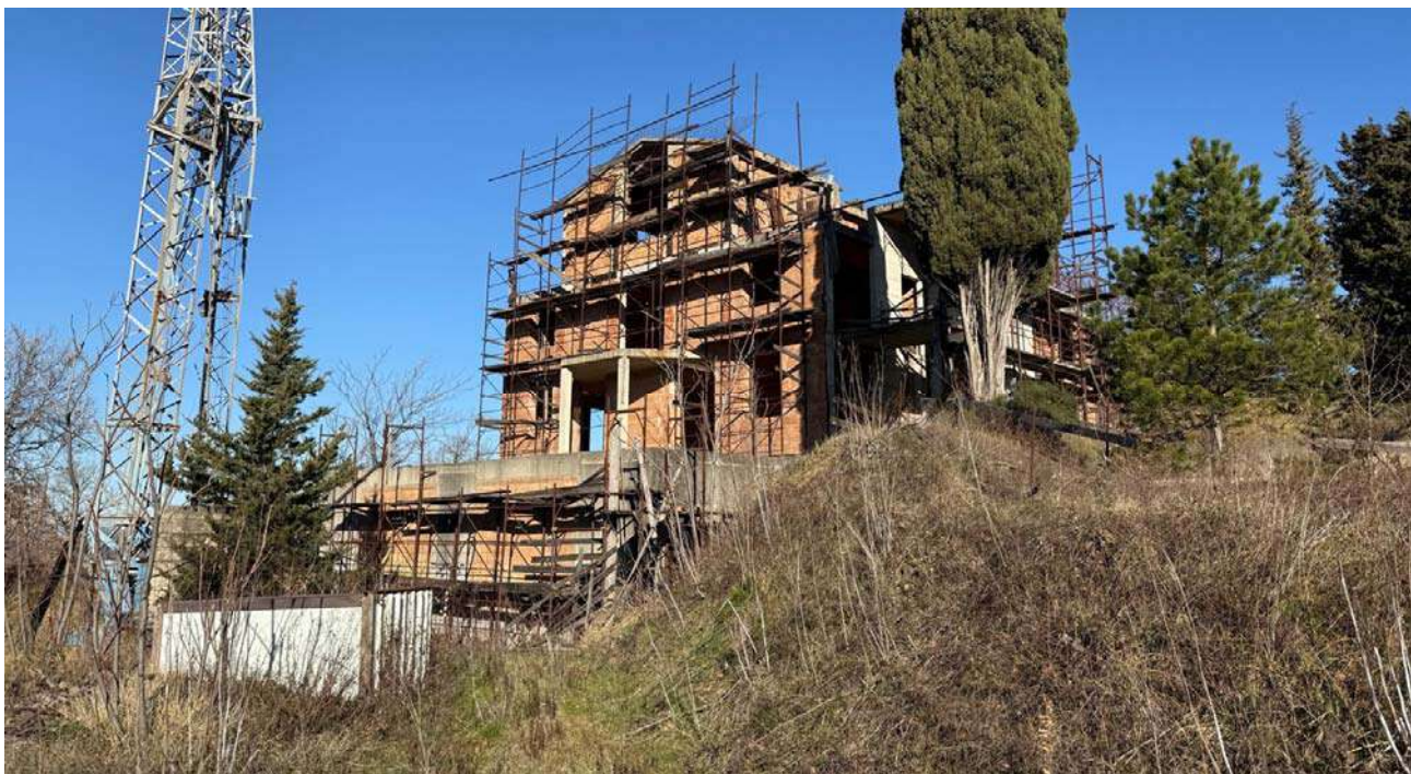
Figura 2: Vista frontale del fabbricato
