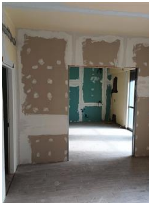
Ingresso Cucina - appartamento 1
