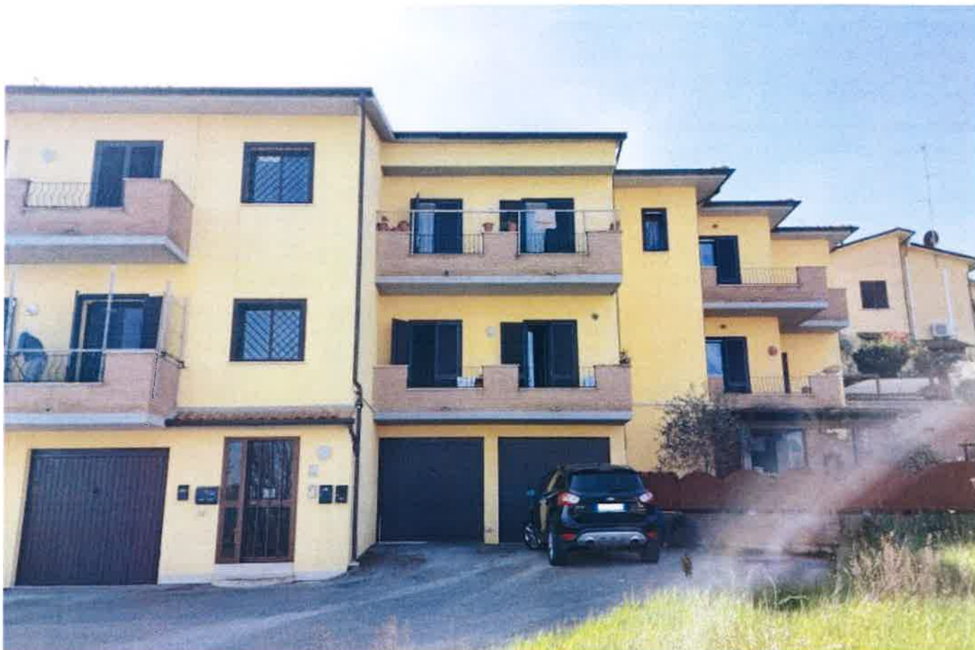
Foto 1 - Prospetto Nord della costruzione ( appartamento al centro - Piano 1° )
