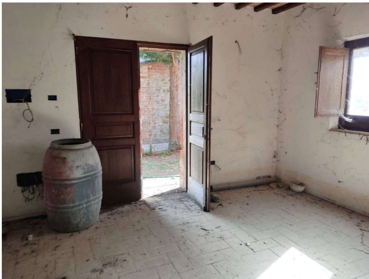
Appartamento "D" (sub. 11) – soggiorno PT
