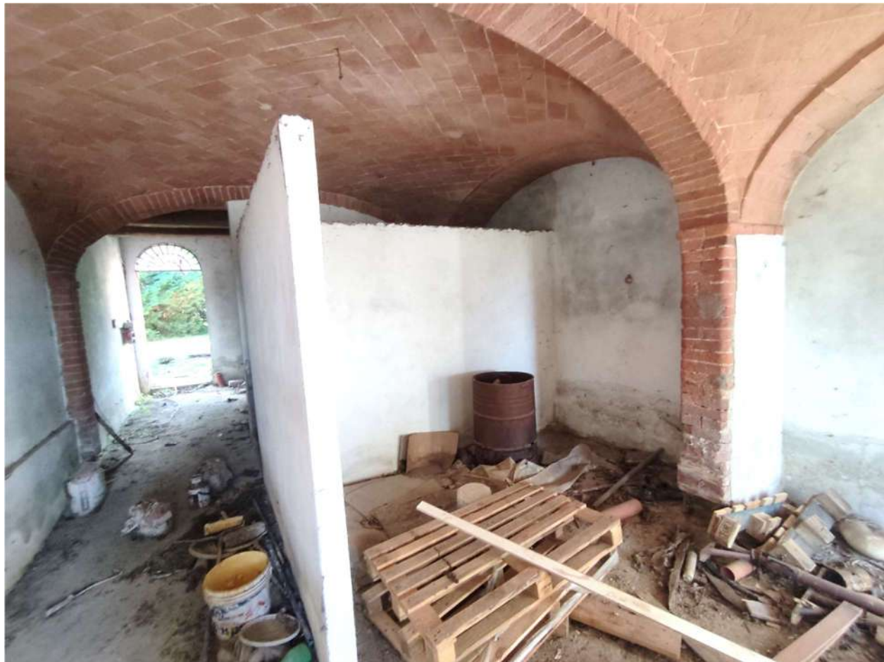
Appartamento “A” (sub. 8 ) – bagno PT
