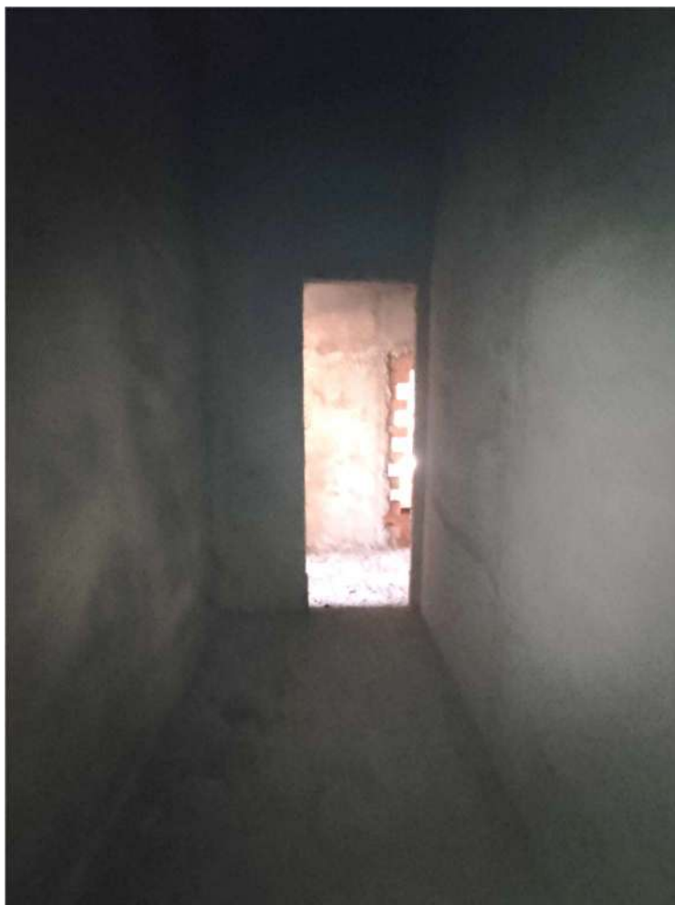
Appartamento "A" (sub. 8 ) – bagno N-O P1
