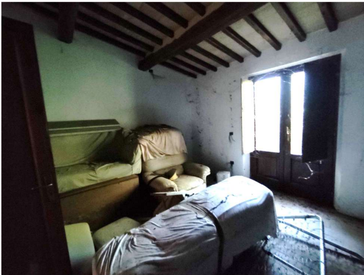
Appartamento “D” (sub. 11) – camera PT
