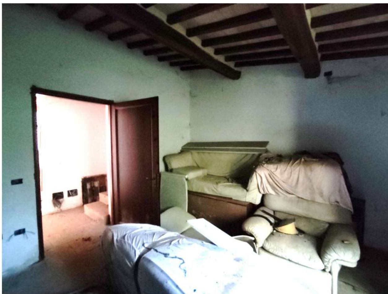
Appartamento “D” (sub. 11) – camera PT
