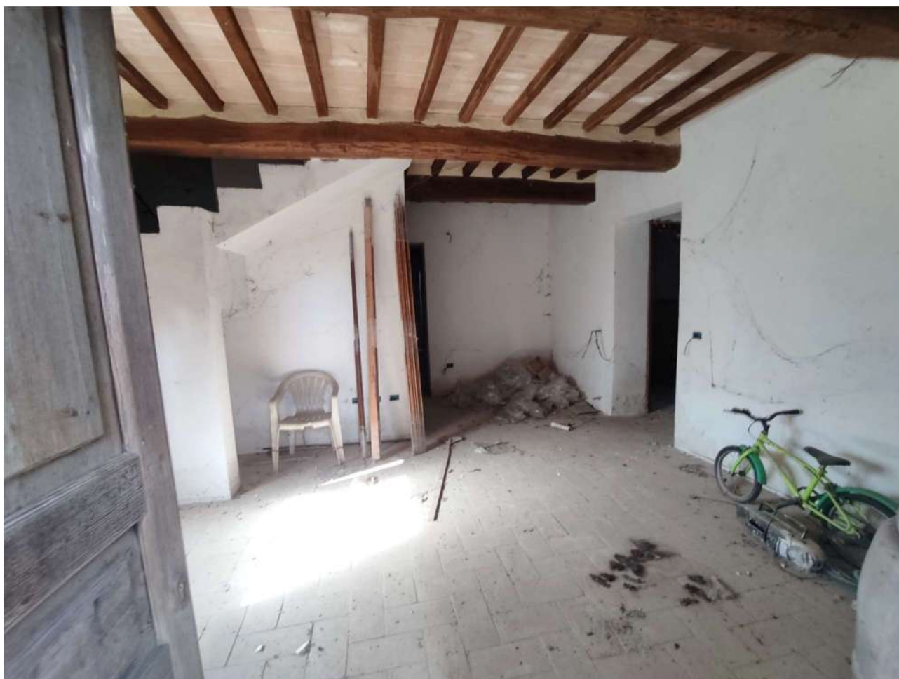
Appartamento “D” (sub. 11) – soggiorno PT
