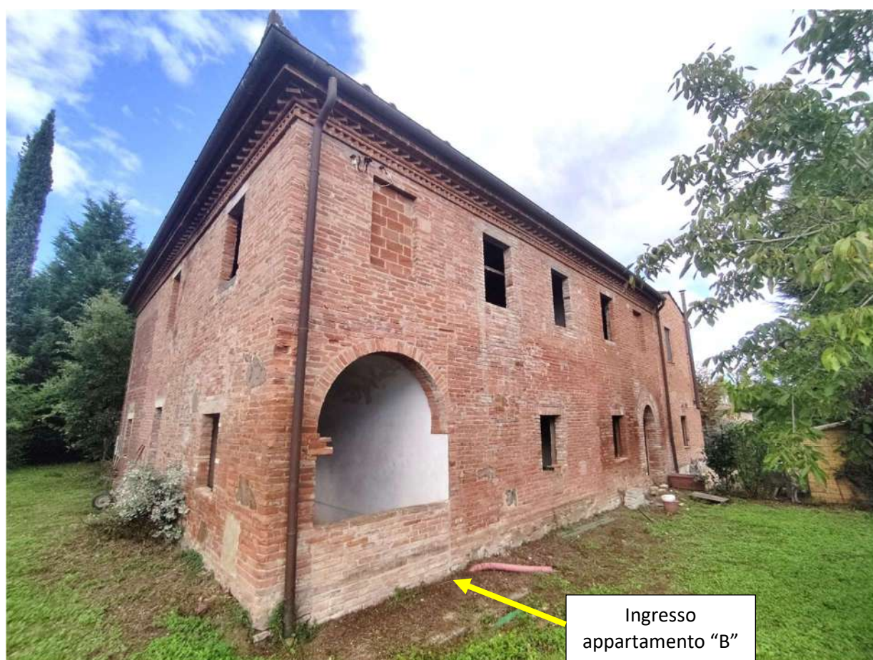
Retro dell'edificio sub 8 e corte sub 9
