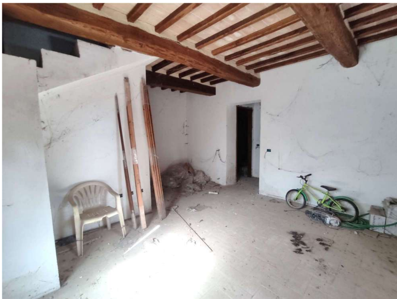
Appartamento "D" (sub. 11) – soggiorno PT
