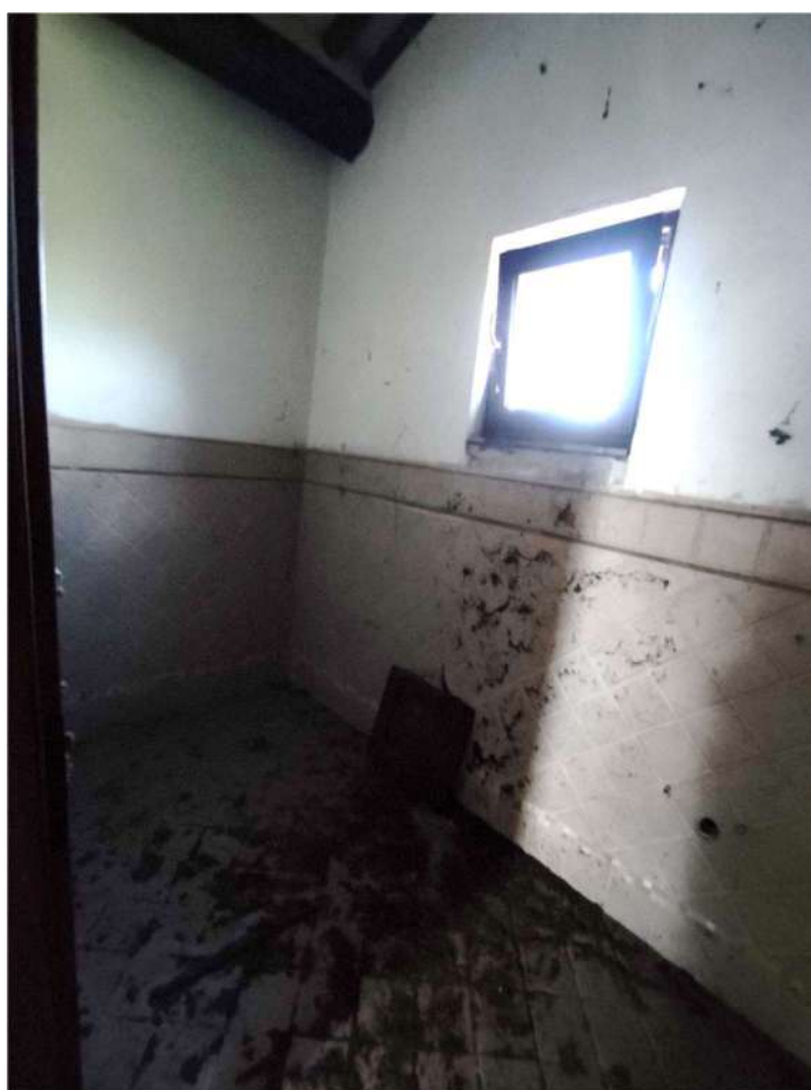
Appartamento “D” (sub. 11) – bagno P1
