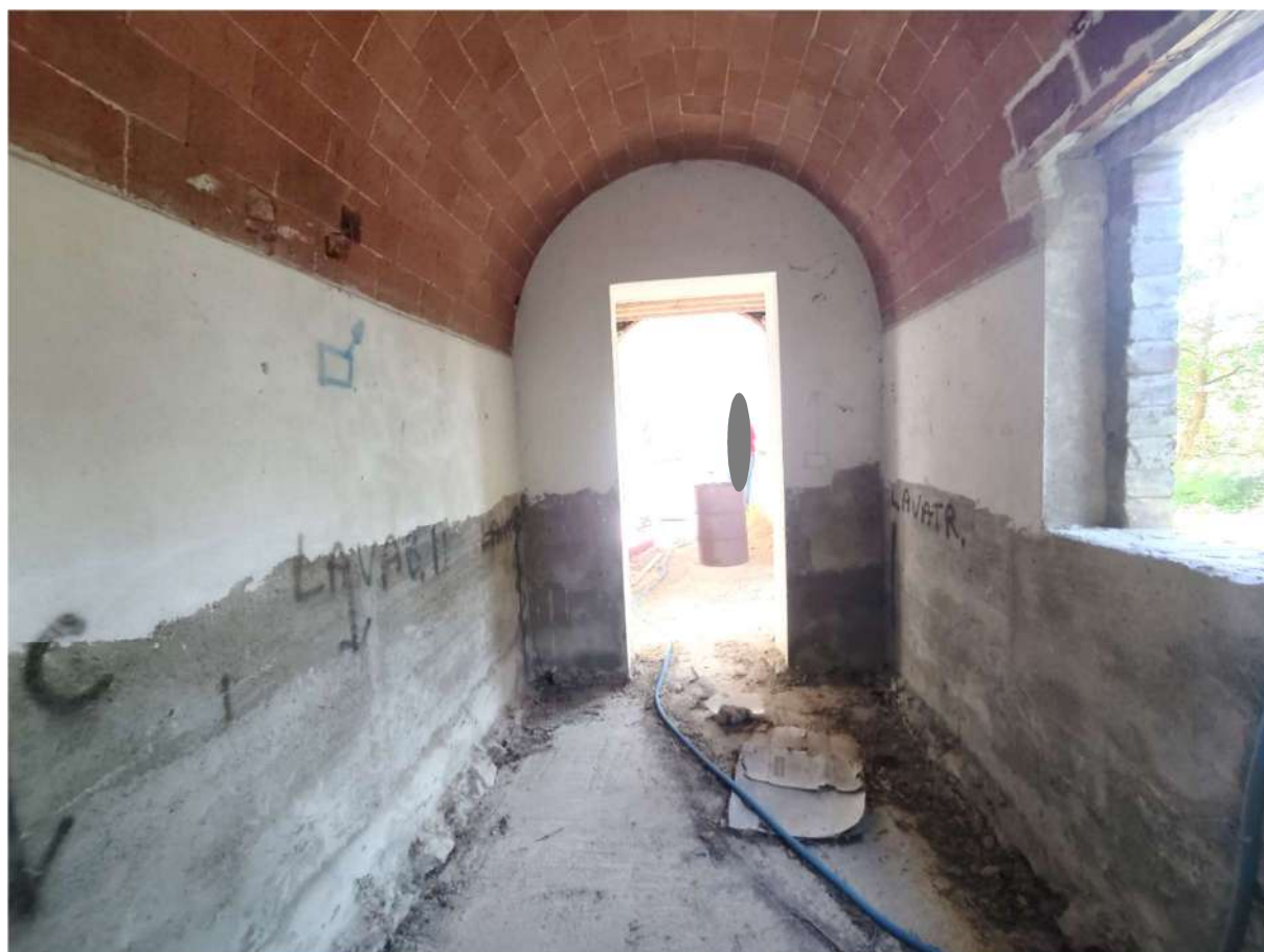
Appartamento "B" (sub. 8) – antibagno e bagno PT
