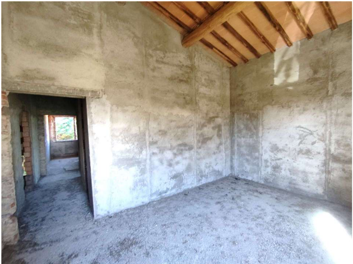
Appartamento “A” (sub. 8 ) – camera N-E P1
