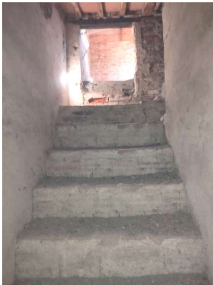
Appartamento “C” (sub. 8 ) – scale che conducono a piano 2
