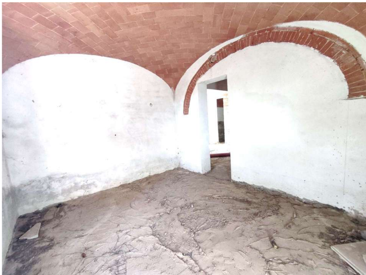
Appartamento “B” (sub. 8 ) – soggiorno PT
