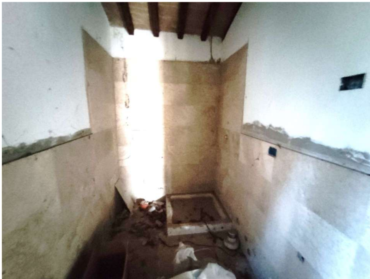
Appartamento “D” (sub. 11) – bagno PT
