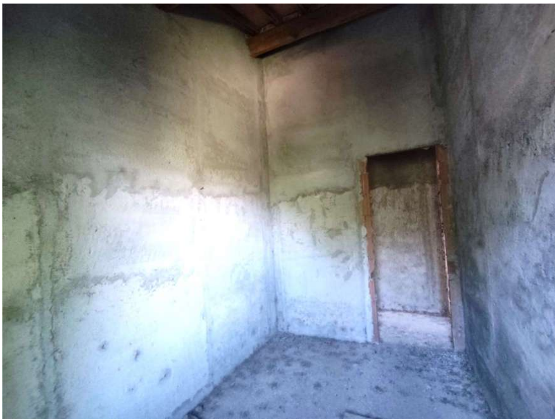
Appartamento “A” (sub. 8 ) – bagno N-O P1
