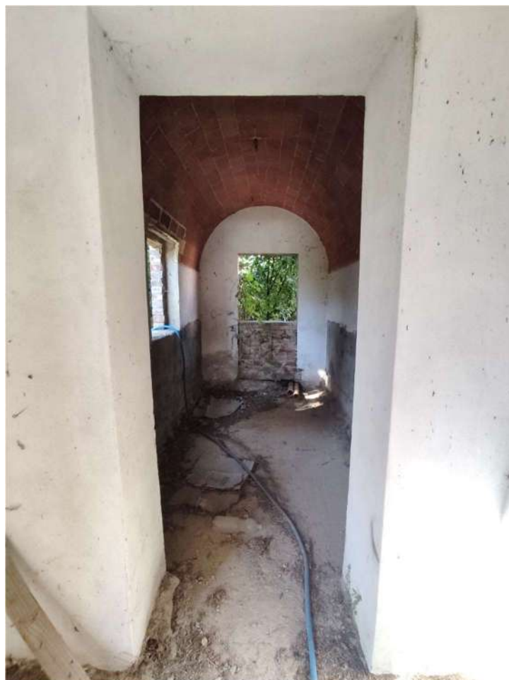
Appartamento "B" (sub. 8) – antibagno e bagno PT
