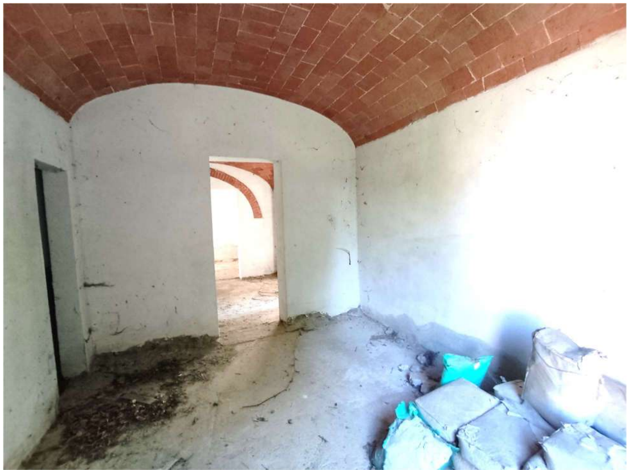
Appartamento “B” (sub. 8 ) – Camera O PT
