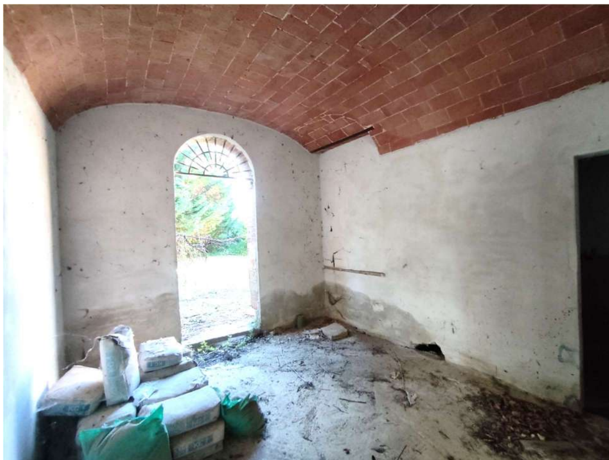
Appartamento “B” (sub. 8 ) – Camera O PT
