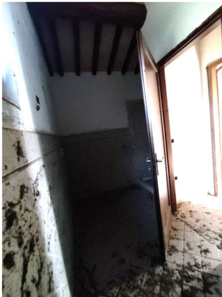
Appartamento “D” (sub. 11) – bagno P1
