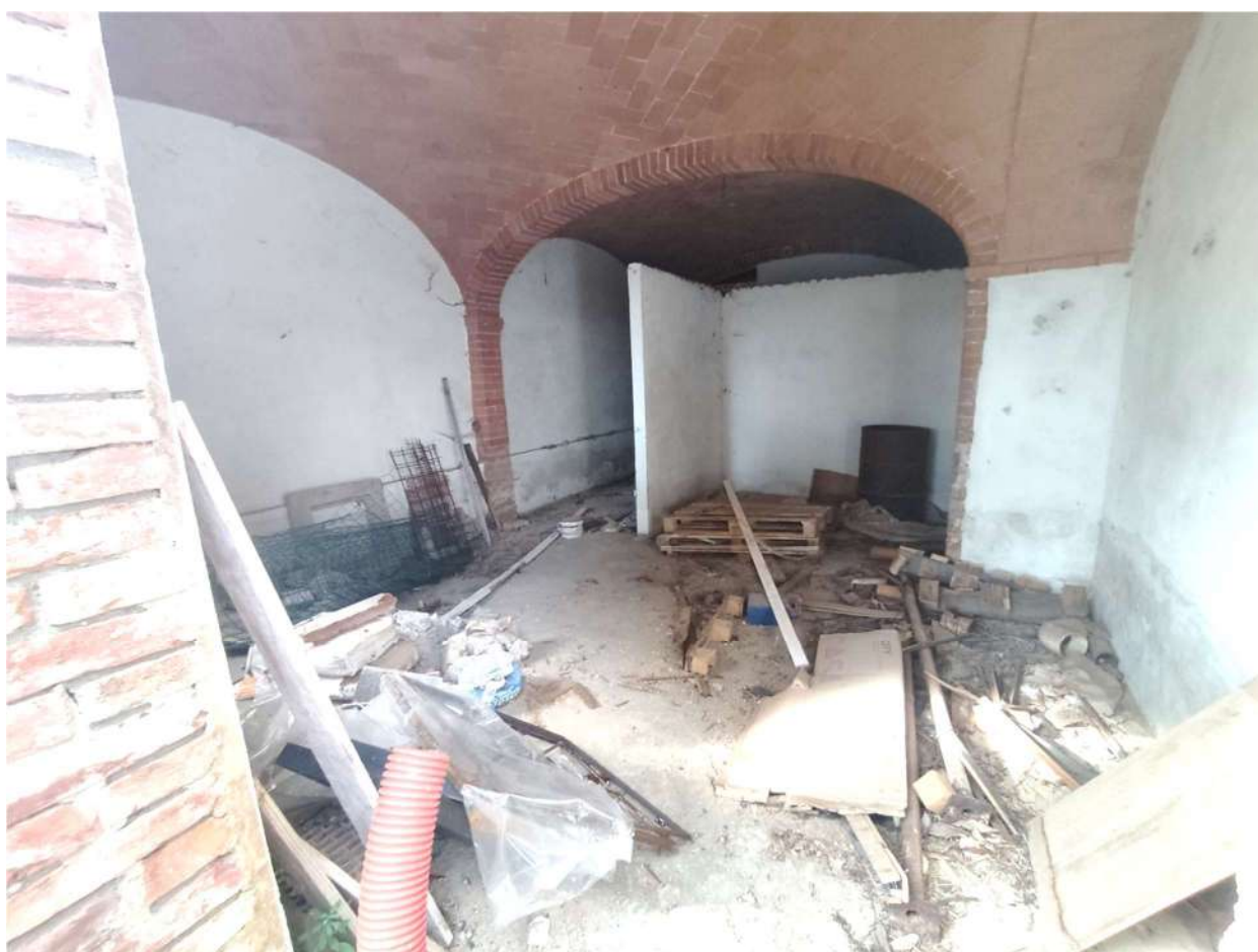
Appartamento “B” (sub. 8 ) – camera N-E PT
