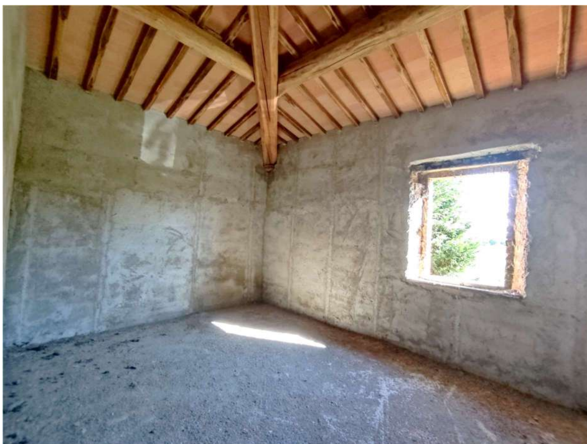
Appartamento "A" (sub. 8 ) – camera N-E P1
