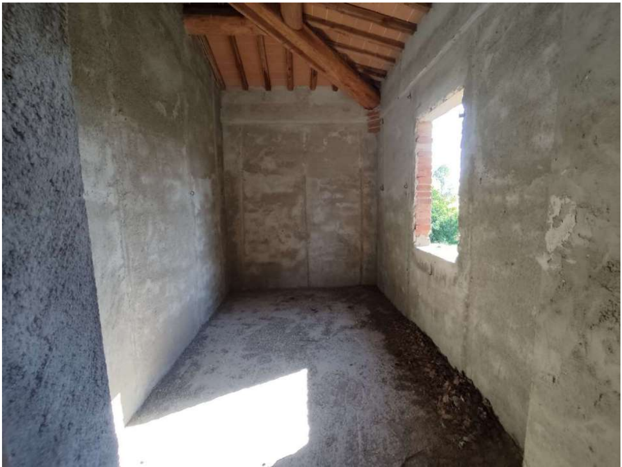
Appartamento "C" (sub. 8 ) – camera S-E P1
