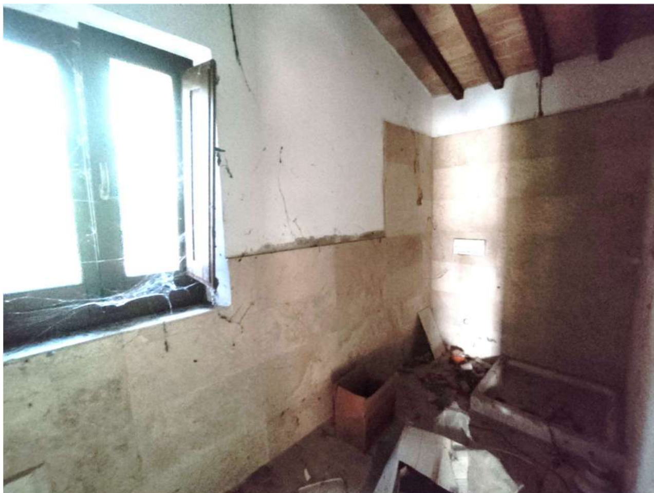
Appartamento “D” (sub. 11) – bagno PT
