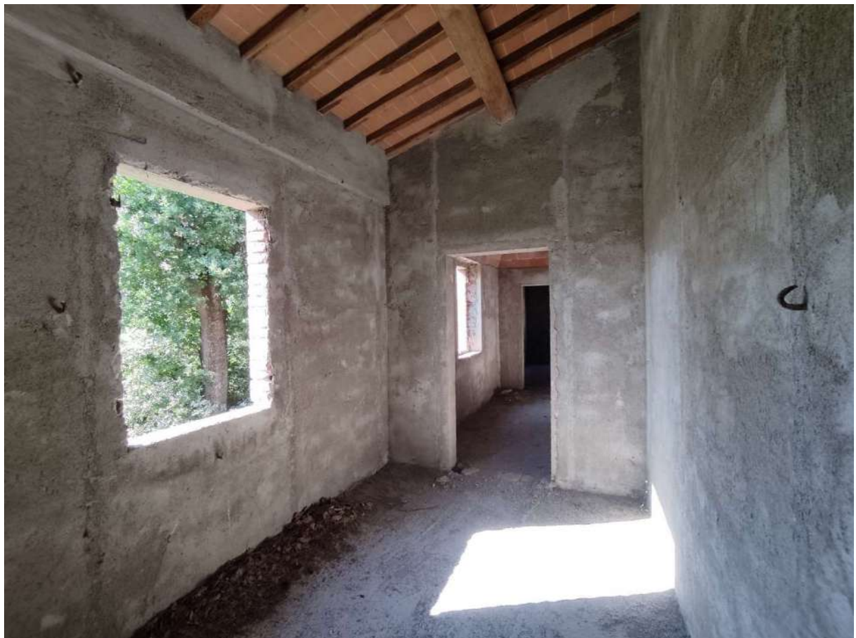
Appartamento "C" (sub. 8 ) – camera S-E P1
