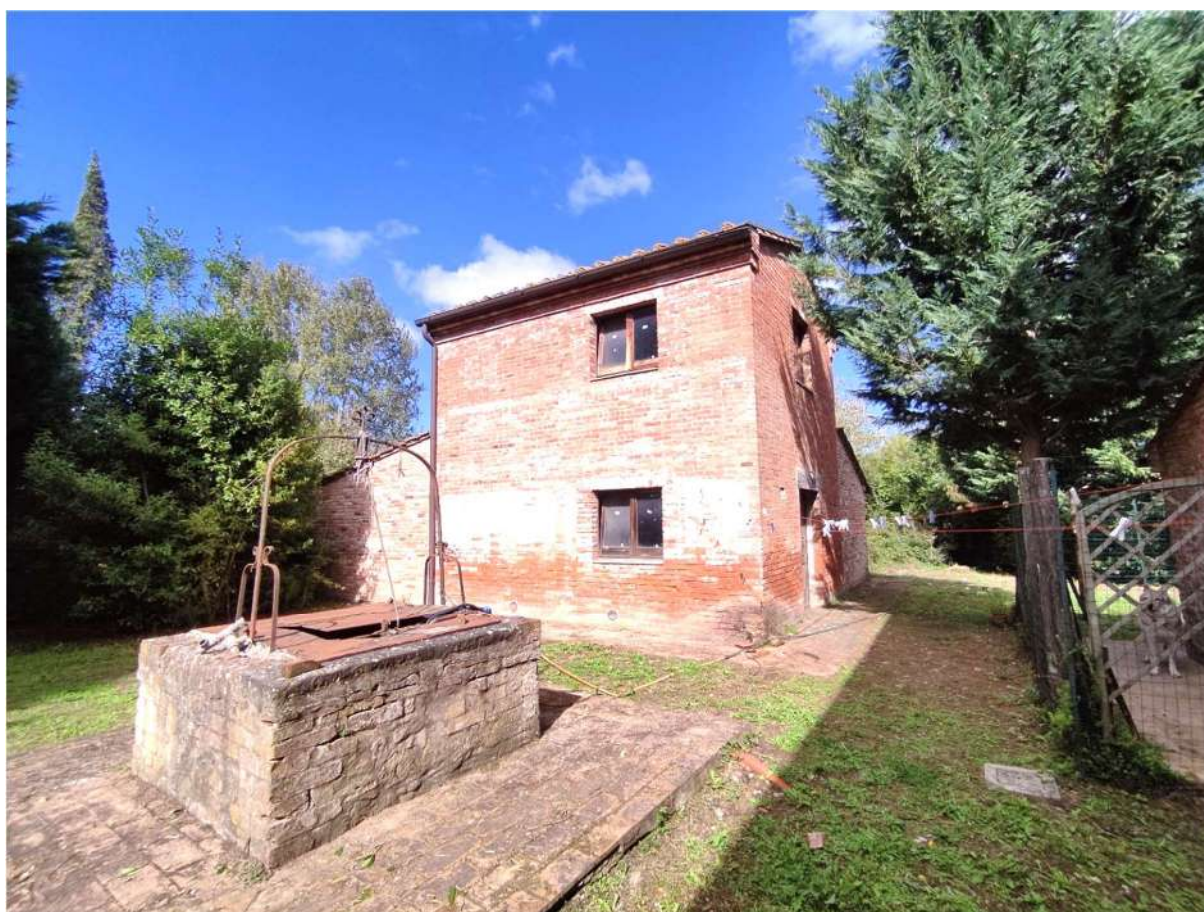
Esterno del complesso (edificio sub 11 e corte sub 12)
