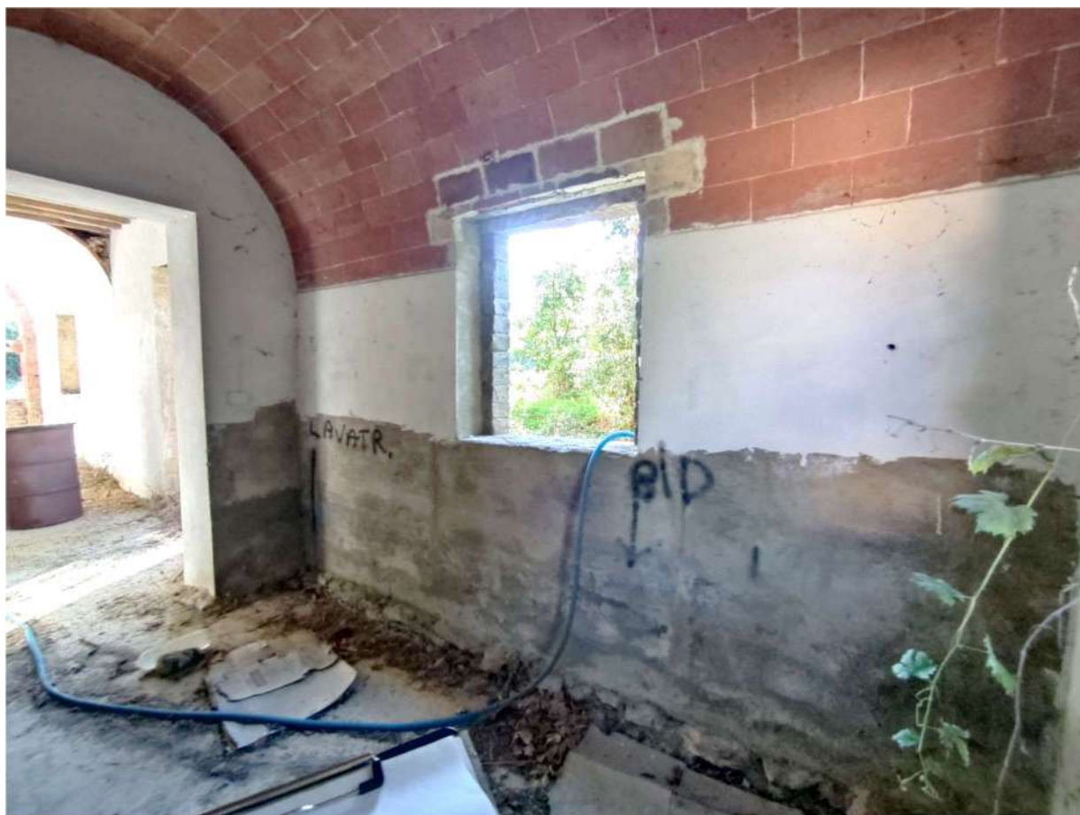
Appartamento "B" (sub. 8 ) – antibagno e bagno PT
