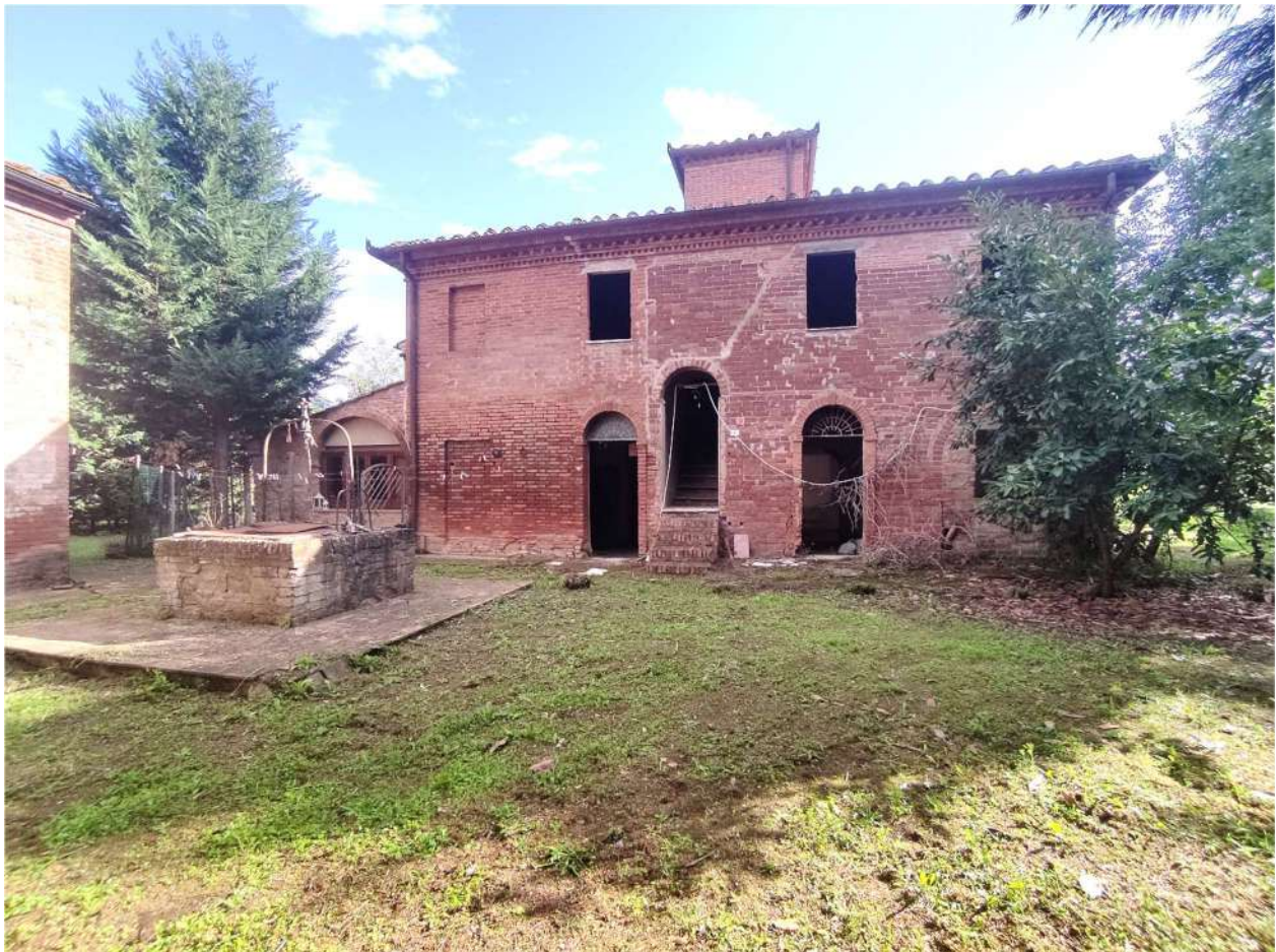
Esterno del complesso (edificio sub 8 e corte sub 9)
