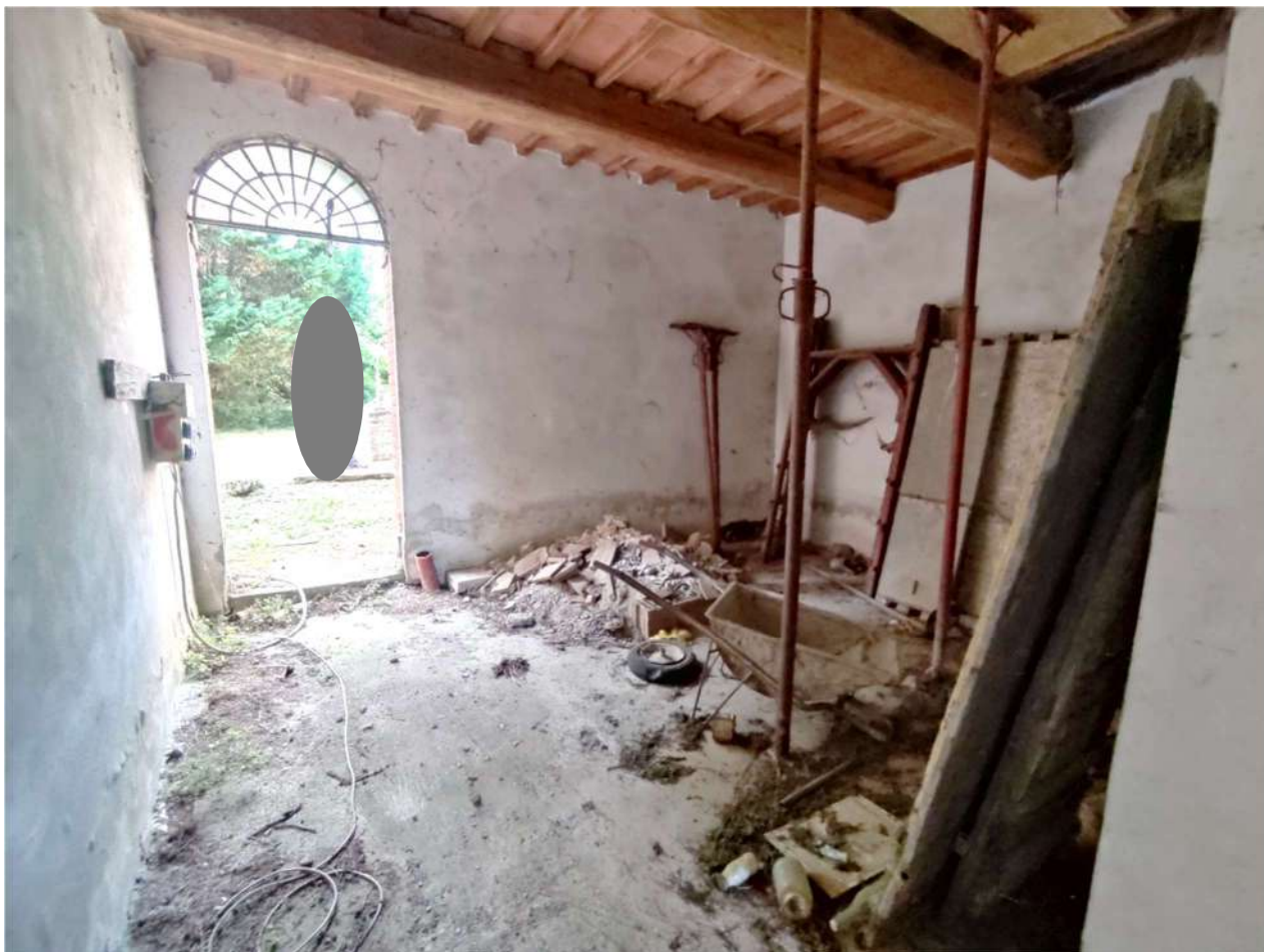
Appartamento “A” (sub. 8 ) – soggiorno con angolo cottura PT
