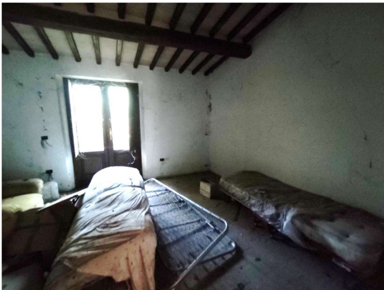
Appartamento “D” (sub. 11) – camera PT
