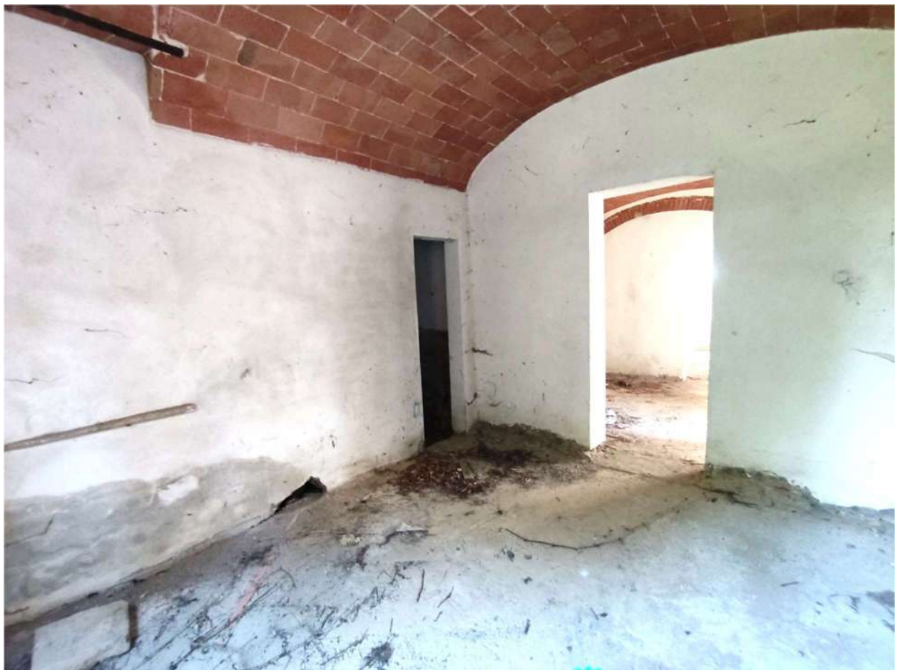
Appartamento “B” (sub. 8 ) – Camera O PT
