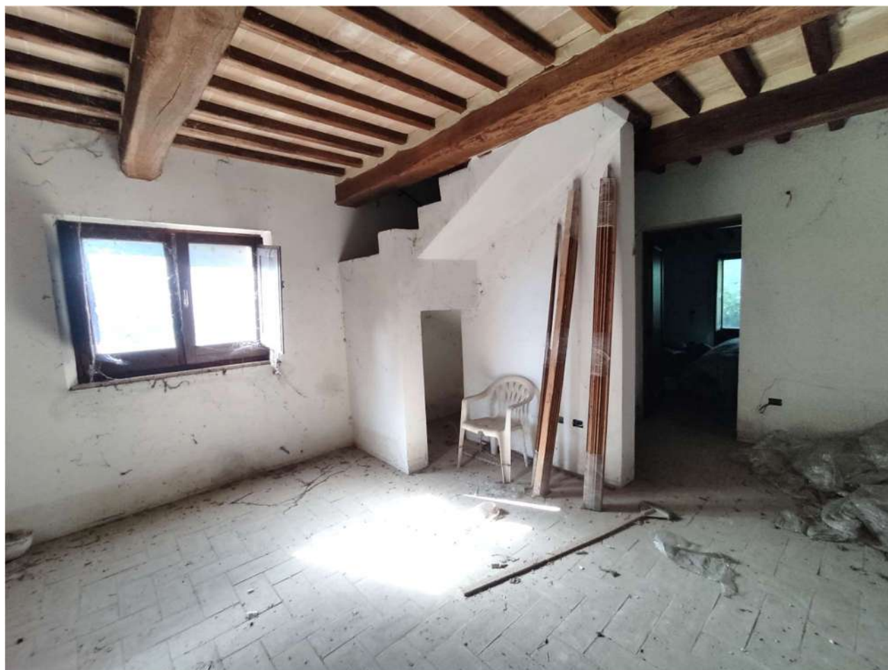
Appartamento “D” (sub. 11) – soggiorno PT
