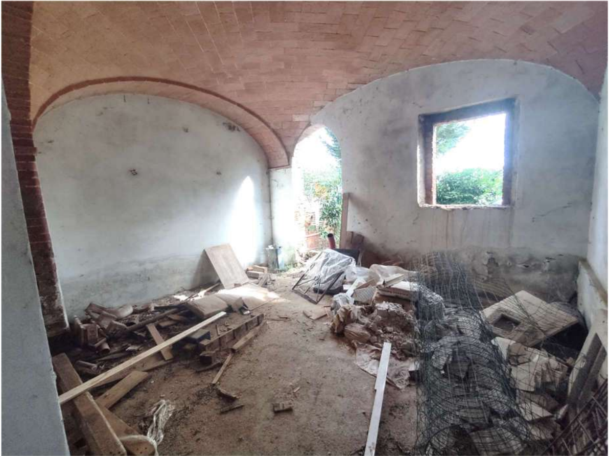
Appartamento "B" (sub. 8 ) – camera N-E PT
