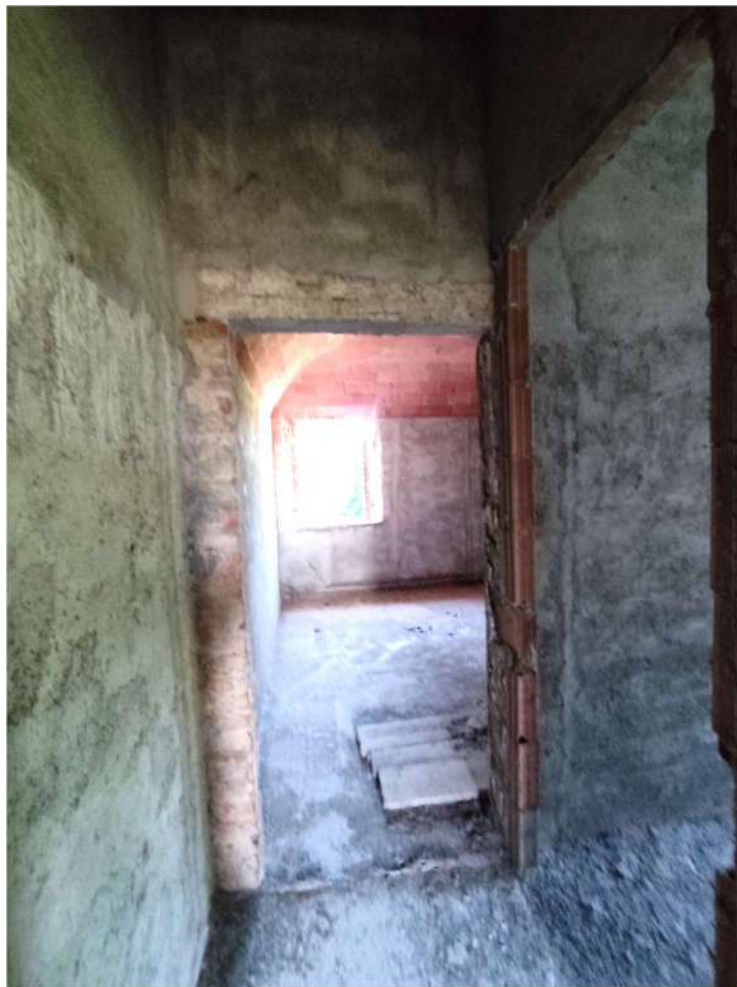
Appartamento "A" (sub. 8 ) – disimpegno P1
