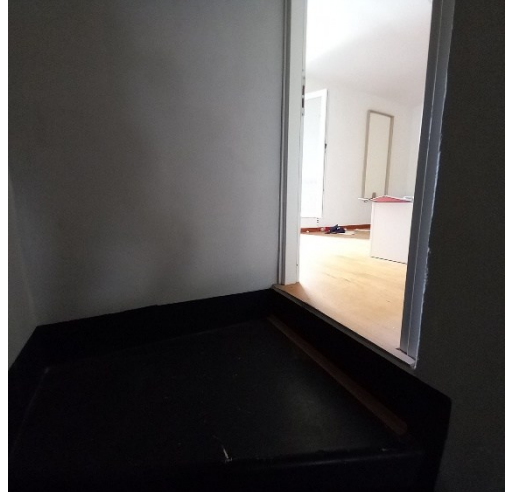
Ingresso camera p2
