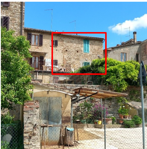
Vista fabbricato prospetto tergale
