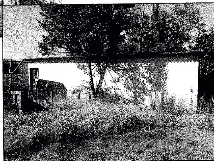
Edificati in muratura di blocchi in cls e in muratura ordinaria di mattoni hanno copertura in onduline, il manufatto minore è anche intonacato e tinteggiato color terroso.
