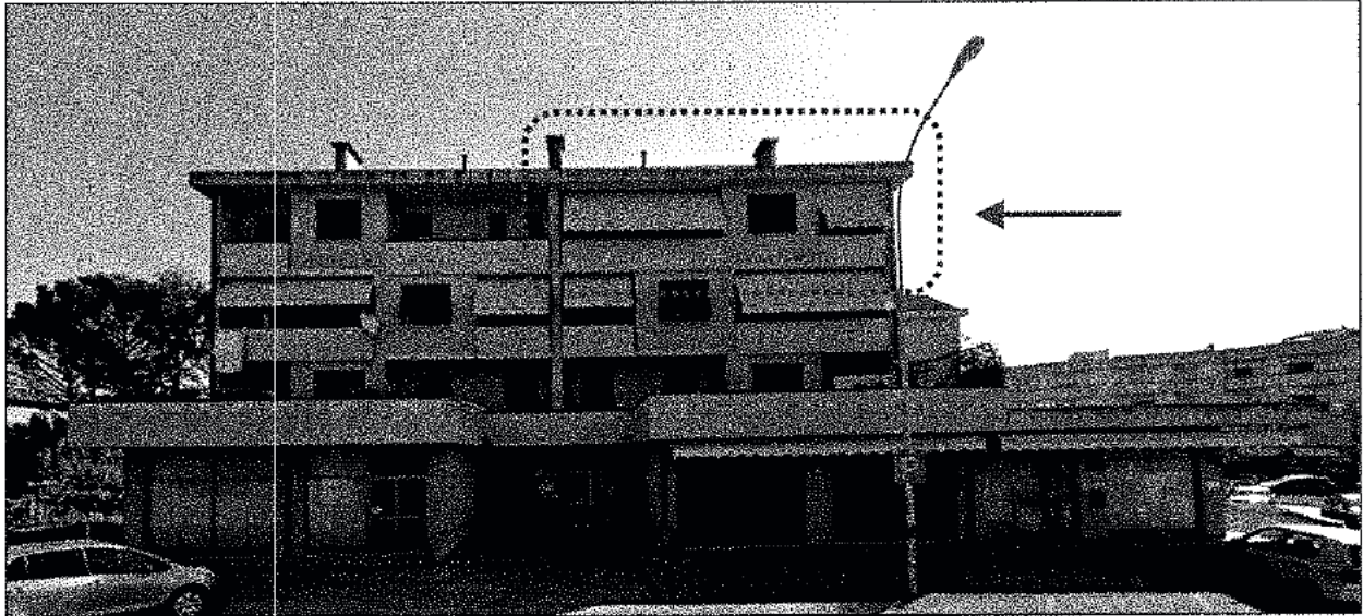
Fronte della palazzina con indicato l'appartamento
