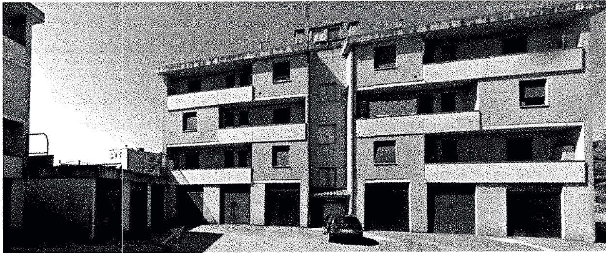
Retro della palazzina con indicato ilgarage
