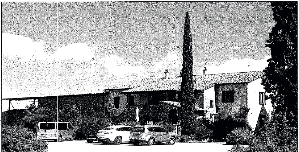
Fronte del fabbricato
