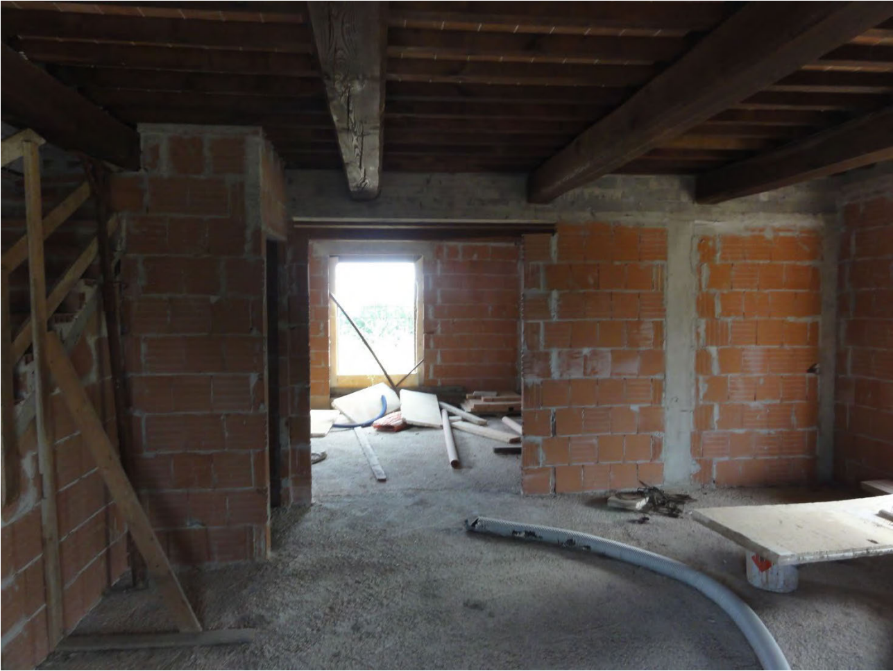
RILIEVO FOTOGRAFICO INTERNO VILLETTA B
