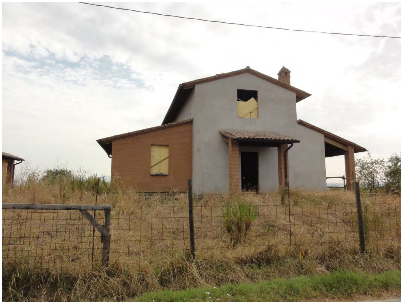
RILIEVO FOTOGRAFICO ESTERNO VILLETTA B
