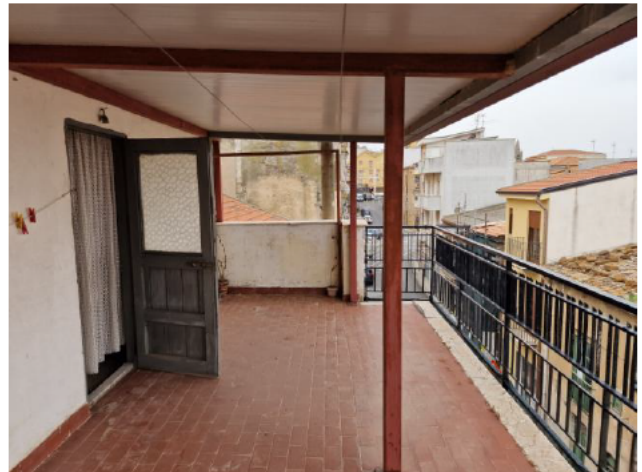
Terrazza coperta in copertura
