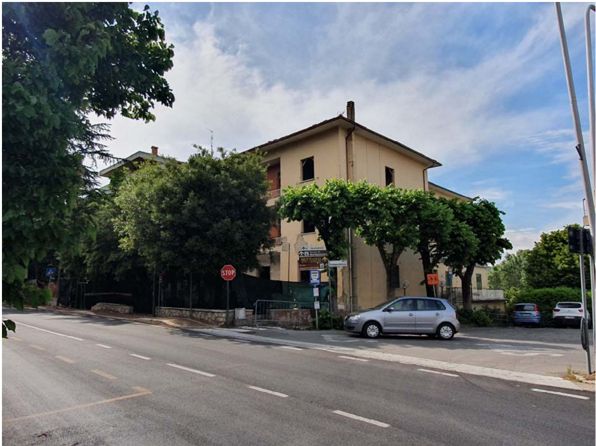
Foto 01 – vista del fabbricato oggetto di perizia
