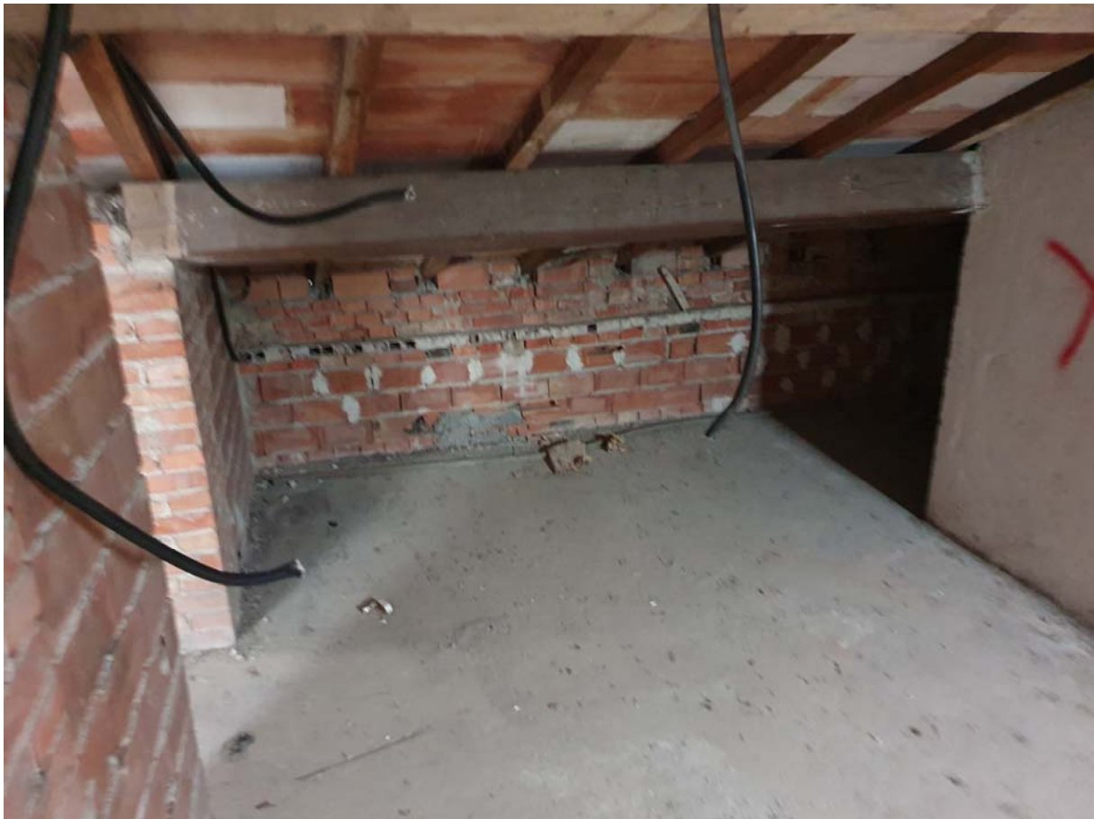
Foto 13 – Vista della soffitta e del tetto
