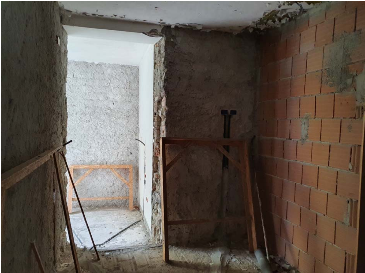
Foto 09 – Vista dei locali a piano 1°
