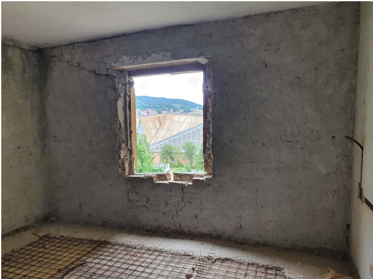
Foto 11 – Vista dei locali a piano 2°
