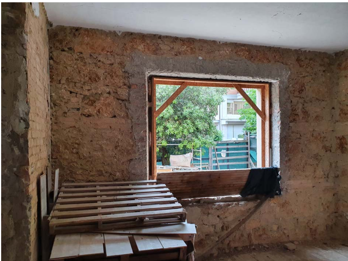
Foto 10 – Vista dei locali a piano 1°
