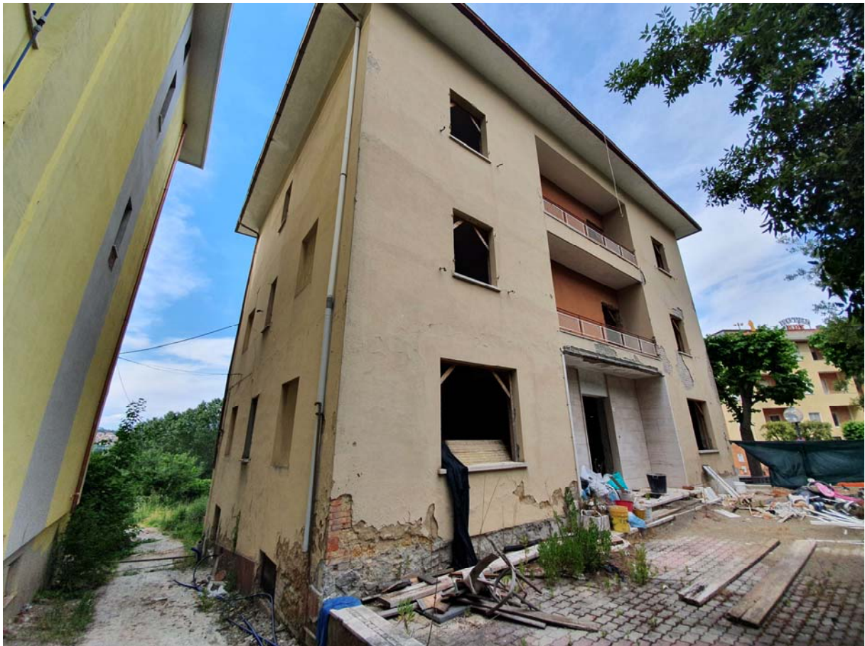
Foto 03 – Vista del fronte del fabbricato oggetto di perizia
