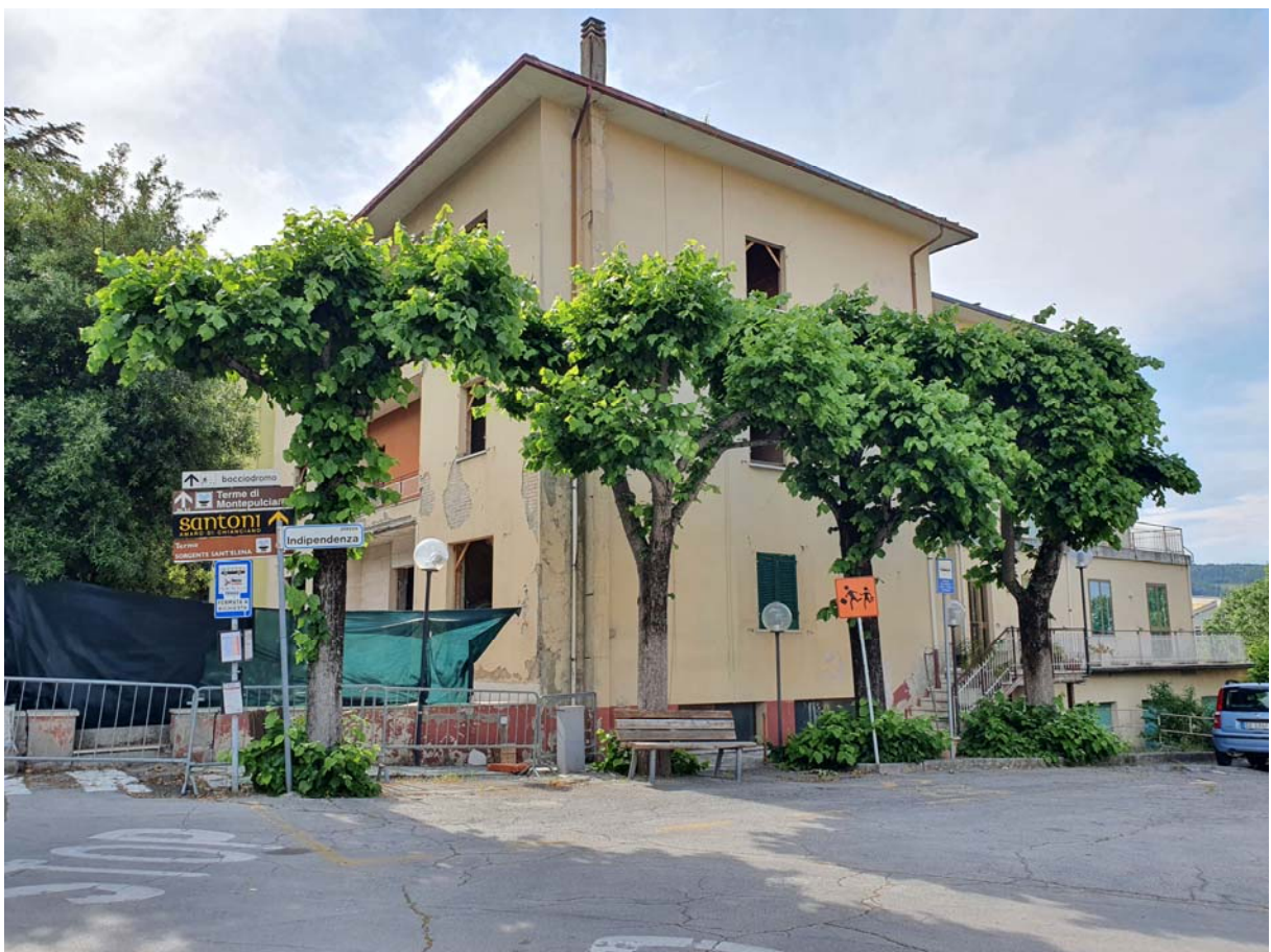
Foto 02 – Vista del fabbricato oggetto di perizia
