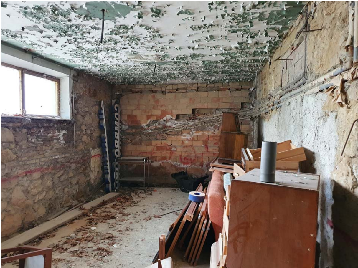
Foto 05 – Vista dei locali a piano seminterrato
