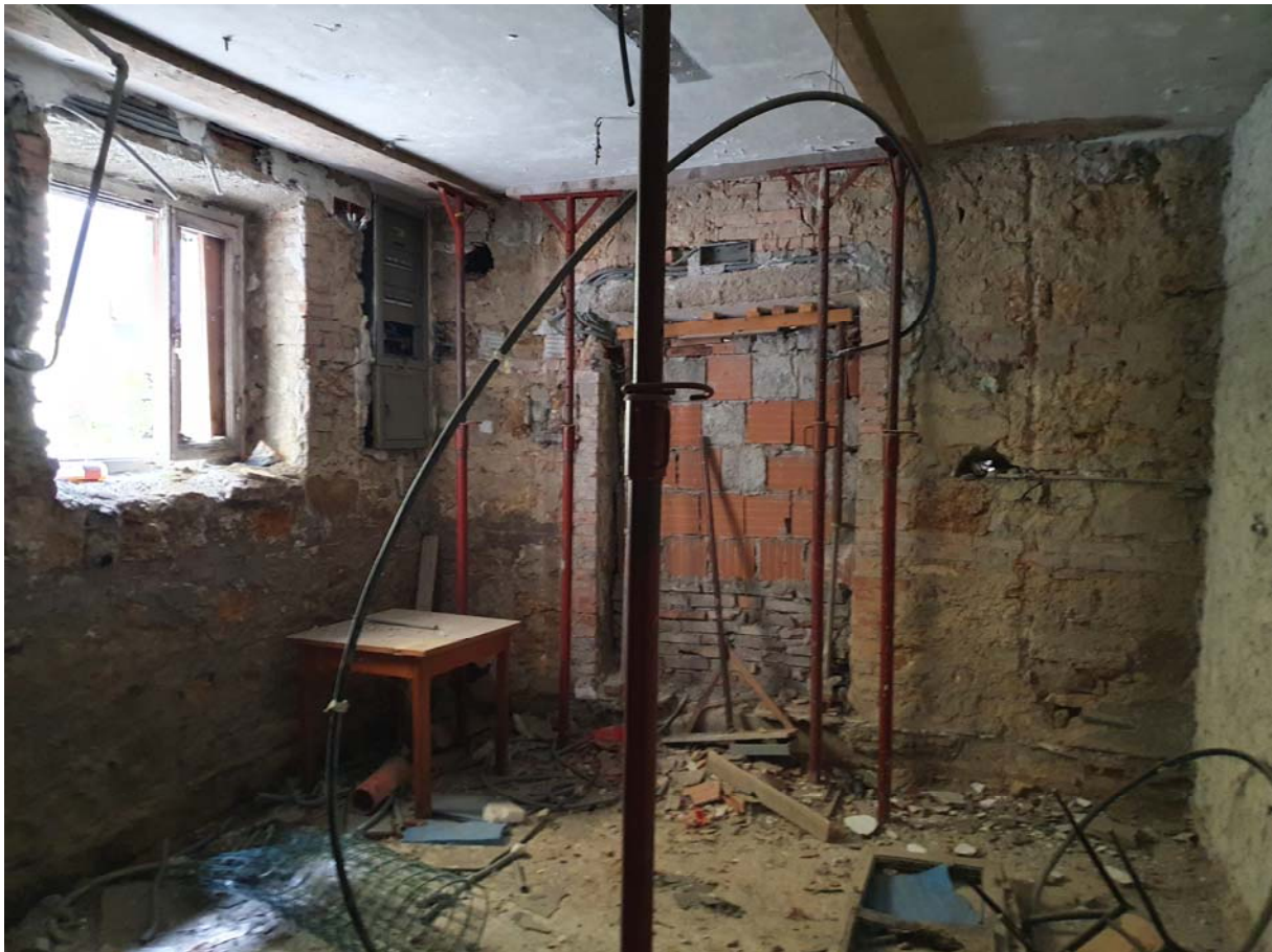
Foto 07 – Vista dei locali a piano terreno
