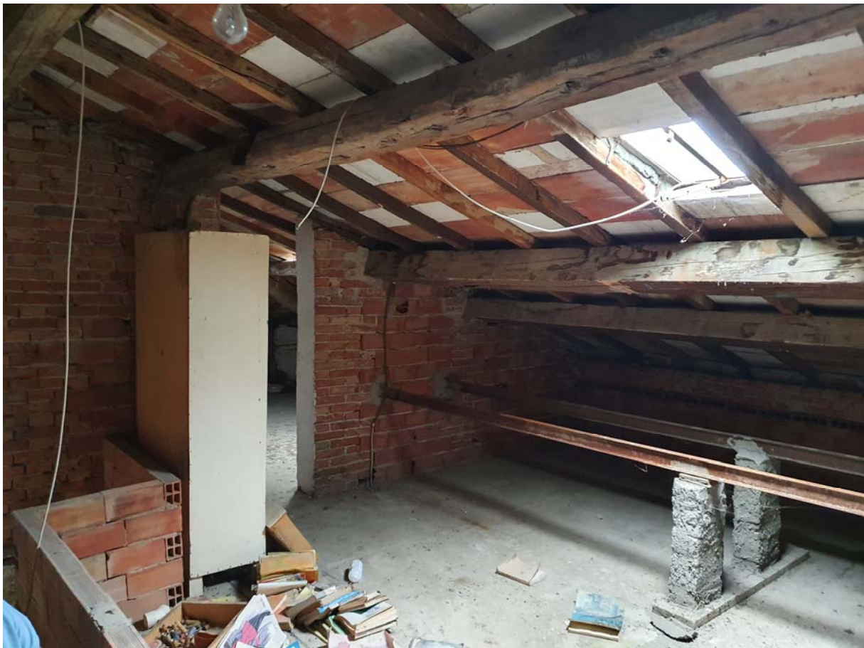
Foto 14 – Vista della soffitta e del tetto
