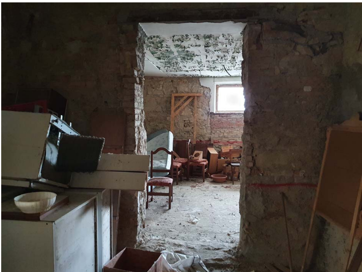
Foto 06 – Vista dei locali a piano seminterrato
