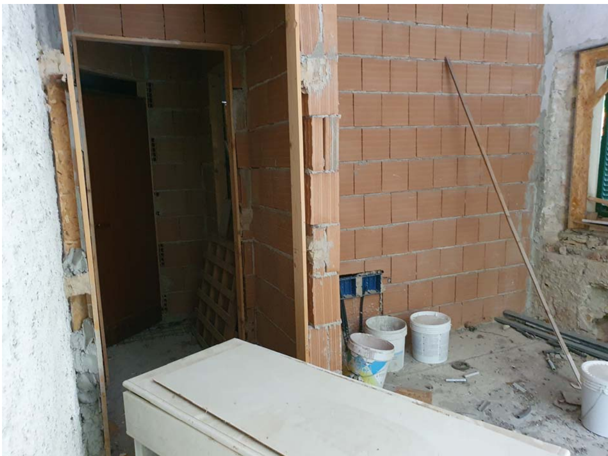
Foto 08 – Vista dei locali a piano terreno
