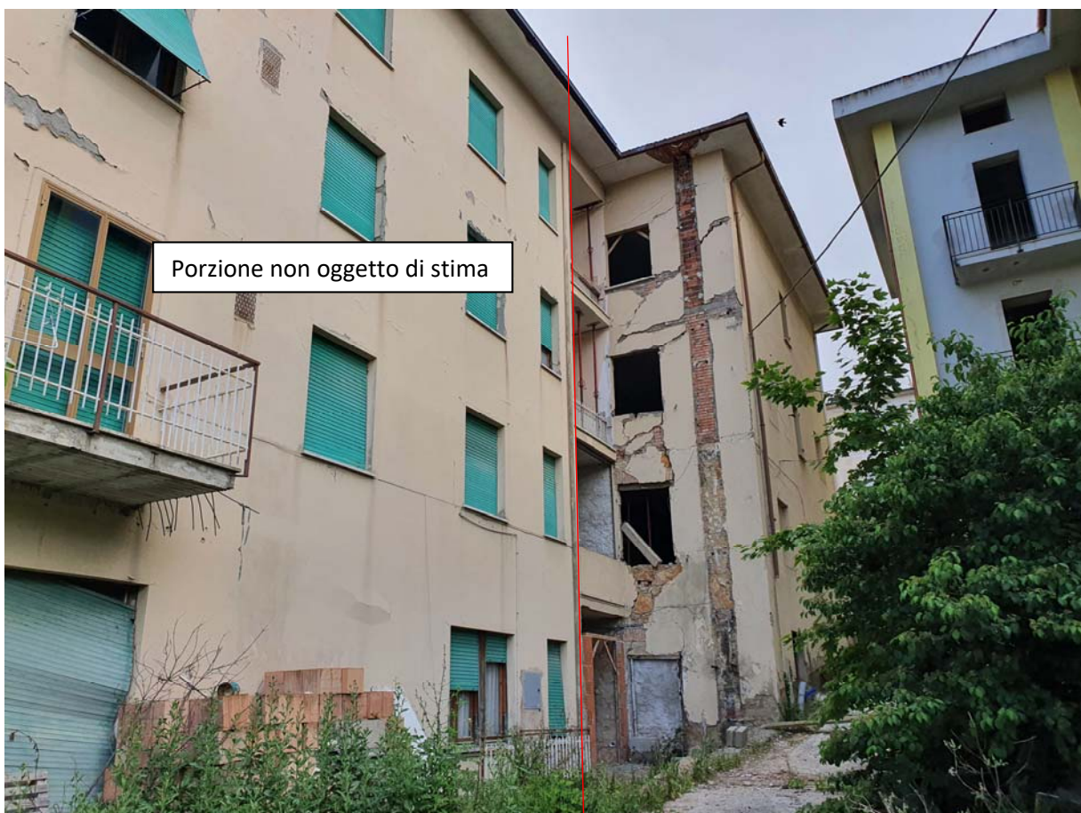
Foto 04 – Vista del retro del fabbricato oggetto di perizia
