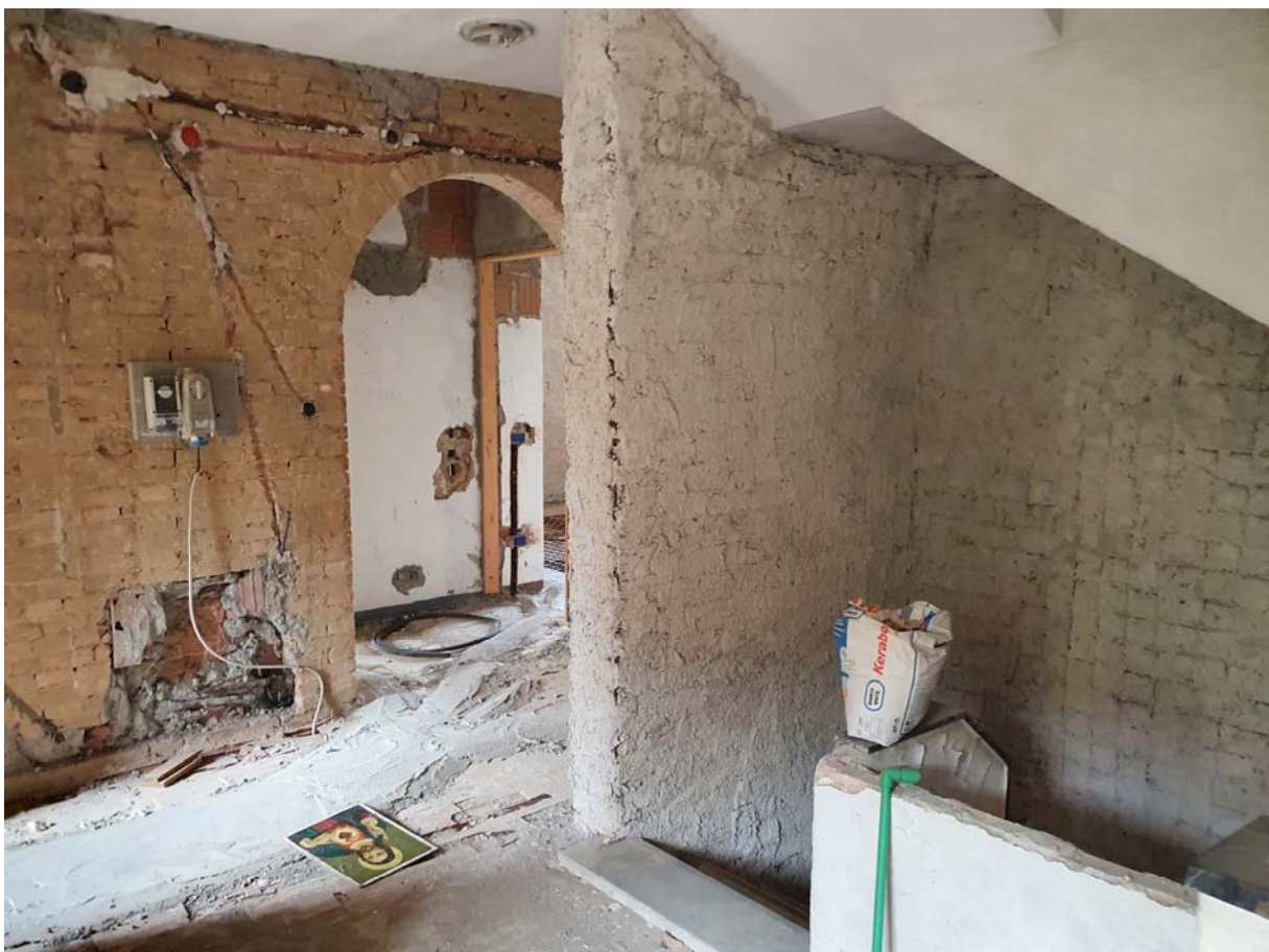
Foto 12 – Vista dei locali a piano 2°
